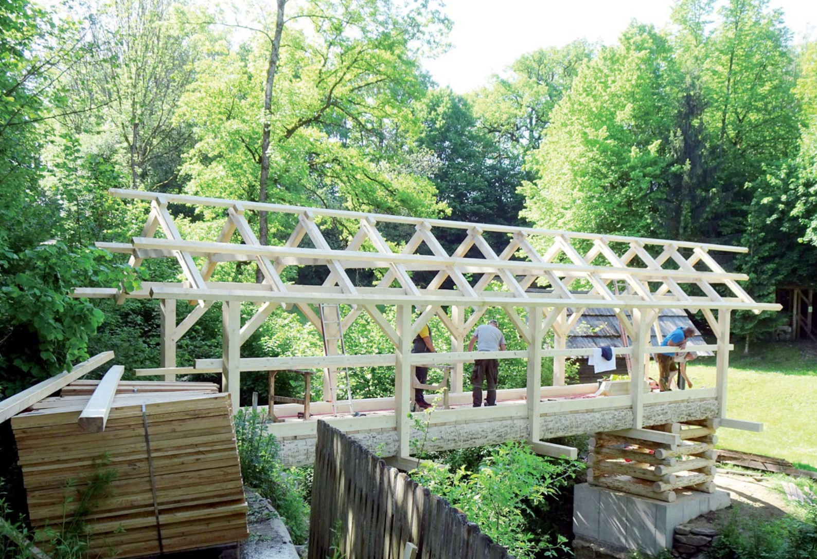
Abb. 2: Aufbau Holzbrücke Fa. Baumgartner. Aufn. H. Schinnerl
