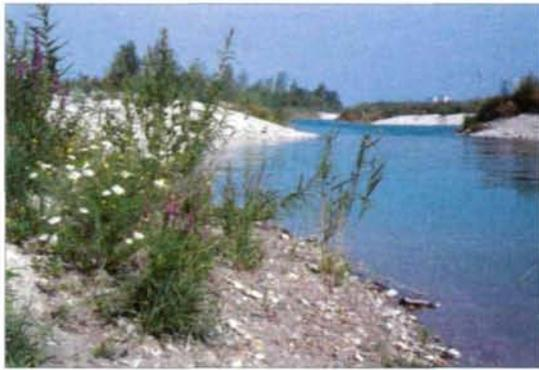
**Abb.6:** Das „Tritonwasser“ nach der Fertigstellung im Sommer 1990. Gut zu sehen sind die Initialpflanzungen und die Grobschotterflächen in den Uferbereichen, die nicht von Schilf besiedelt werden sollten.
