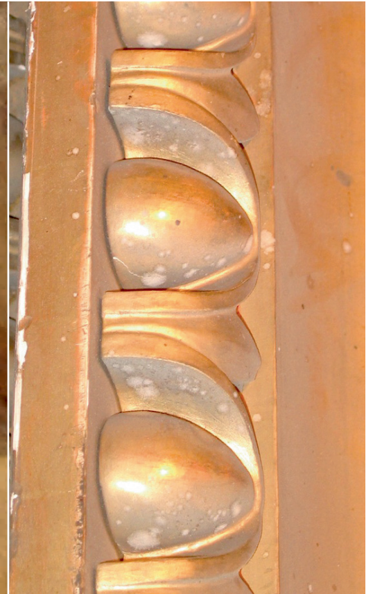
Abb. 12: Schimmelpilzbefall auf vergoldetem Stuckrahmen im Rahmendepot eines Museums (Foto: Sterflinger).
