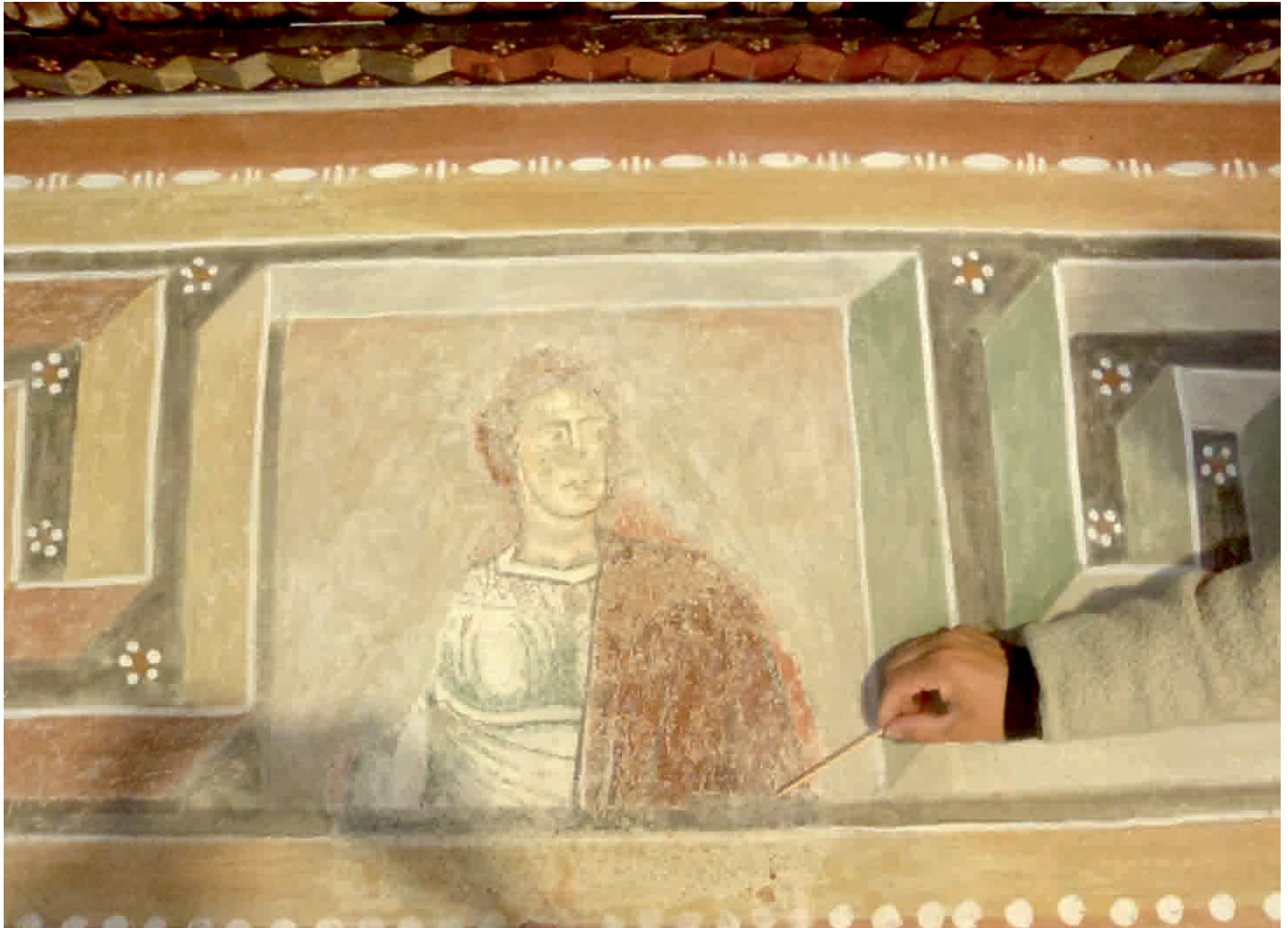
Abb. 17: Ausschnitt aus einer Wandmalerei in einer Kirche mit punktuellen Pilzbefall (Zillis, Schweiz) (Foto: Sterflinger).
