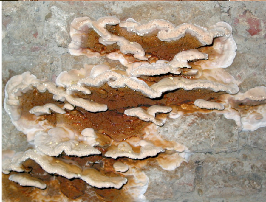
Abb. 10: Fruchtkörper des Echten Hausschwammes auf einer Mauerwerkoberfläche in historischem Gewölbekeller (Foto: Sterflinger).
