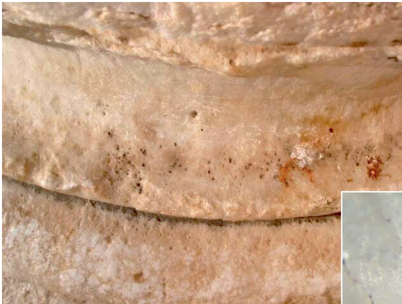
Abb. 3: Schwarze, mikrokoloniale Pilze verursachen Läsionen in einer antiken Marmorsäule (Ephesos, Türkei; Foto: Sterflinger).
