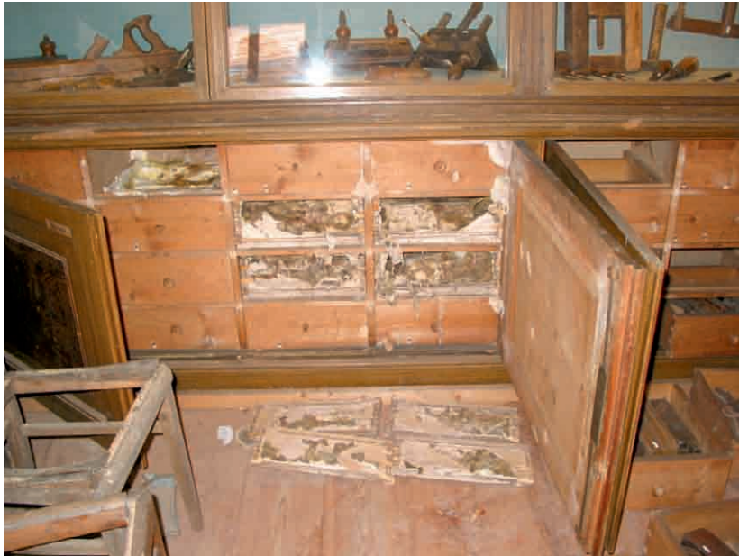
Abb. 8, 9: Zerstörung des Holzbodens, der Vitrinen und der Ausstellungsstücke in einer historischen Drechserei durch den Echten Hausschwamm (Foto: Sterflinger).
