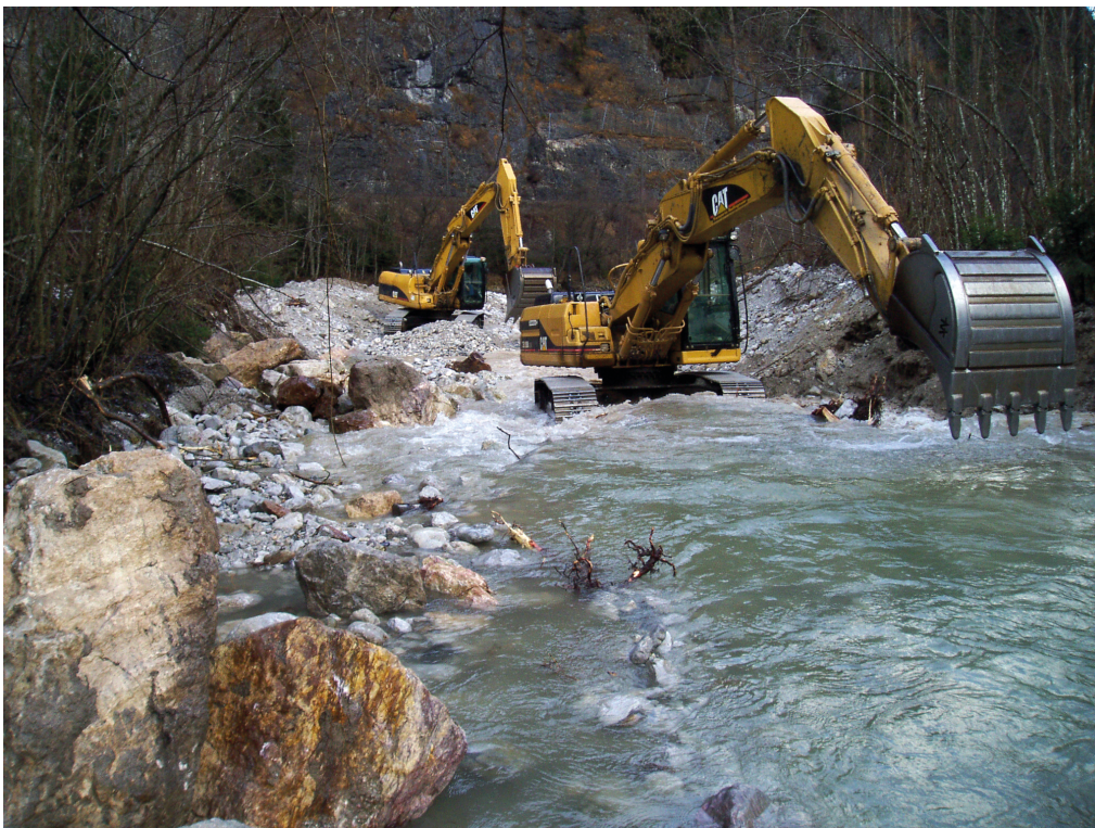
Abb. 3 | Bei der Umsetzung von Maßnahmen am Fluss ist zur Beseitigung von Verbauungen und Errichtung von naturnahen Bauwerken auch schweres Gerät im Einsatz | Foto: H. Haseke
