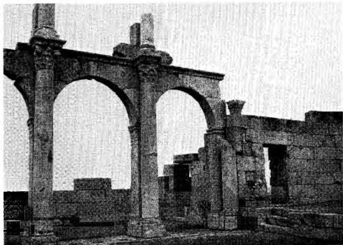
Abb. 29. Tebessa, Klosterkirche. Nordostecke.
