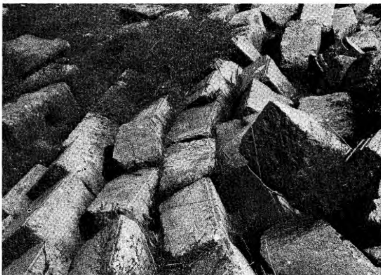
Abb. 11. Anazarbos, Apostelkirche. Südwand in Sturzlage.
