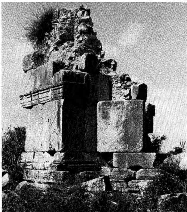
Abb. 9. Anazarbos, Apostelkirche. Südostecke.
