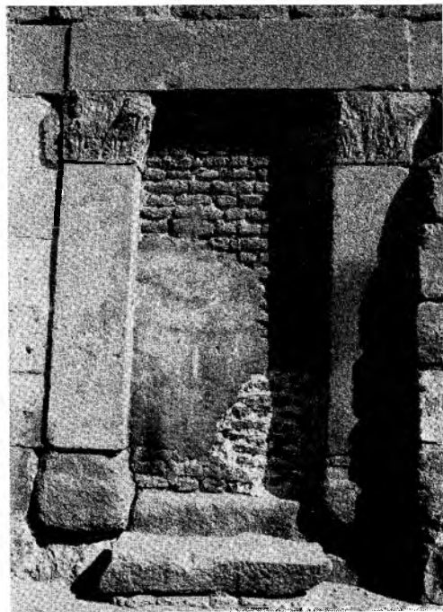
Abb. 23. Der el Abyad. Südportal der Westseite.
