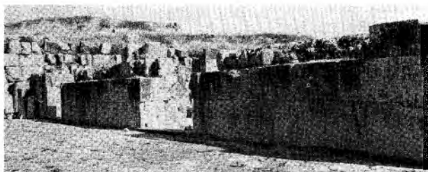
Abb. 19. Gerasa, Kathedrale. Westmauer.
