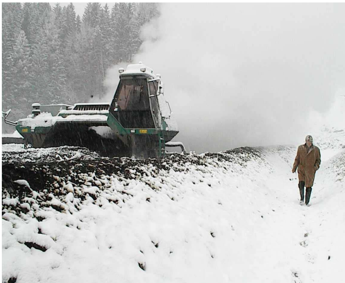
Abbildung 6: Wenden einer Restmüllmiete auf der Deponie Frohnleiten
