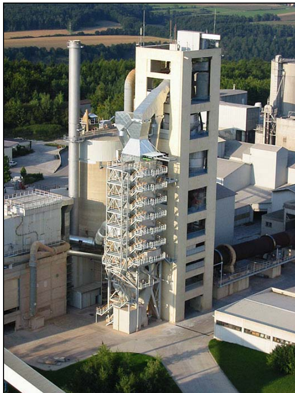
Abbildung 29: SCR Betriebsanlage im Zementwerk Solnhofen [SAUTER & SAMANT, 2003]
