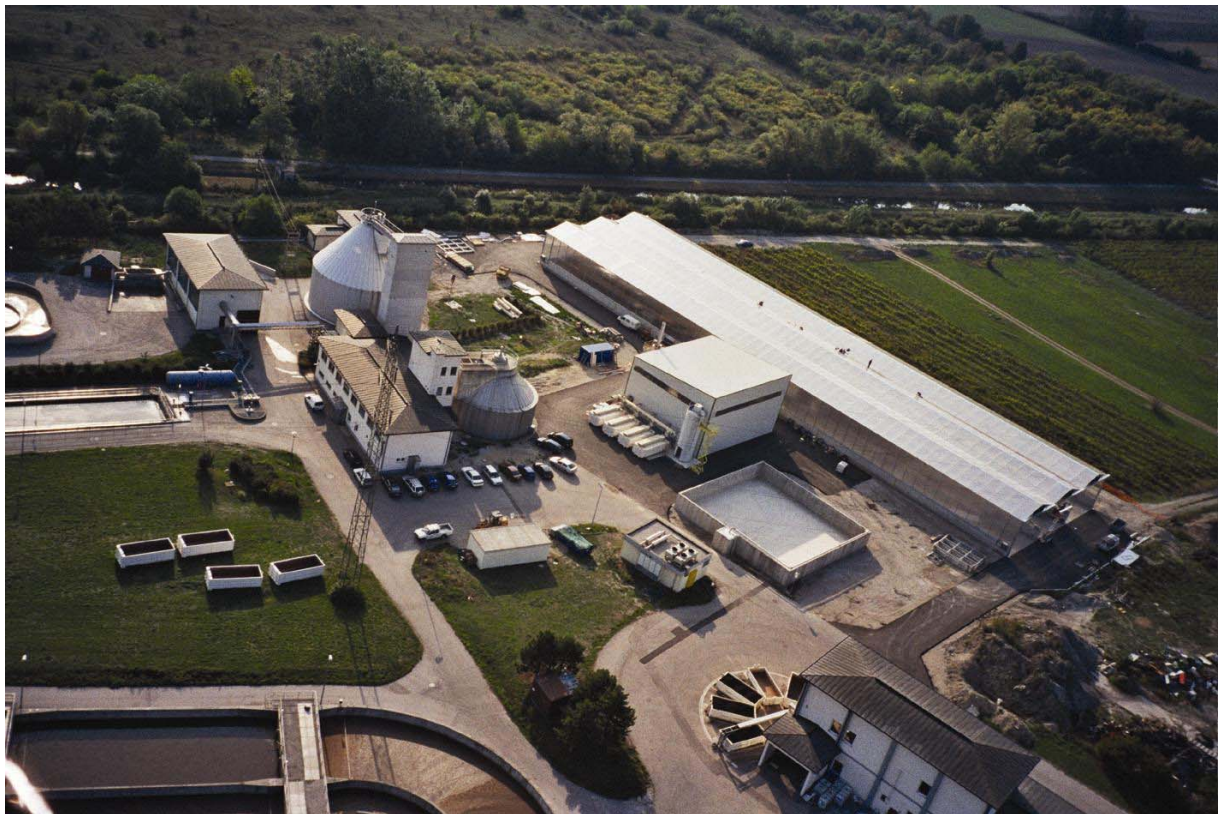
Abbildung 6: Erste Kalogeo Anlage in Österreich auf dem Gelände der Kläranlage Bad Vöslau/NÖ (Quelle: Tecon Engineering GmbH)
