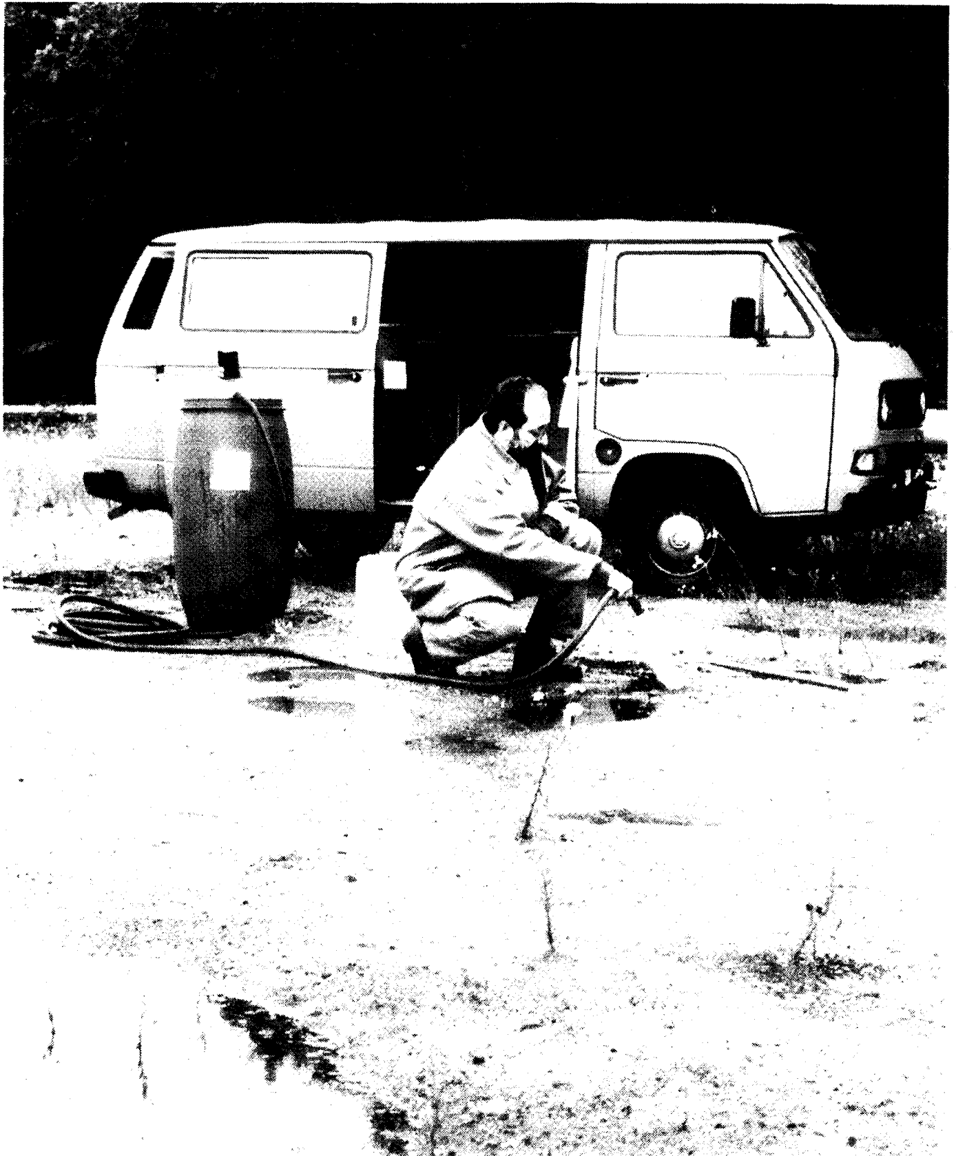
Bild 1: In-situ-Sanierung mit BIOCRACK: Infiltration der Anwendungslösung bei einer Pipeline-Leckage mit versickertem Schadstoff.
