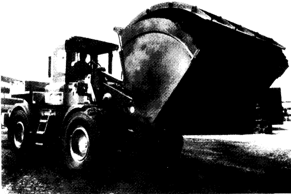
Bild 10: Transport des Boden-Substrat-Gemisches mit einer verschließbaren Radlader Spezialschaufel.
