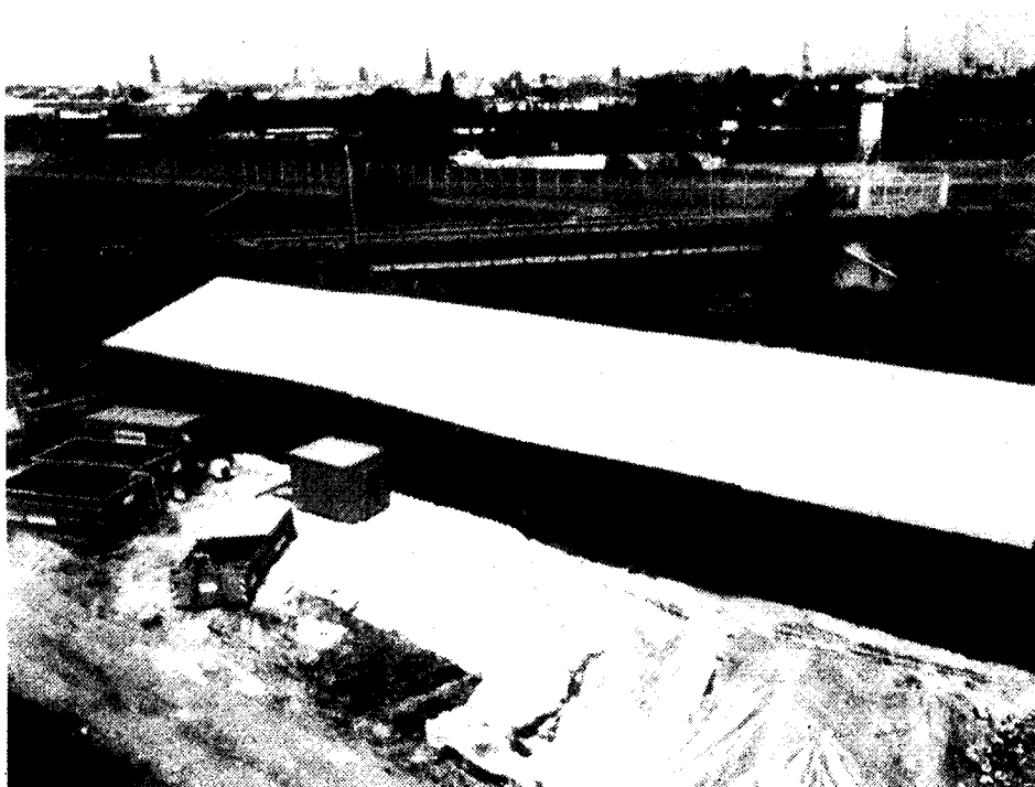
Bild 3: Ausbauzelt zur Vermeidung unkontrollierter Emmissionen in des angrenzende Wohngebiet.
