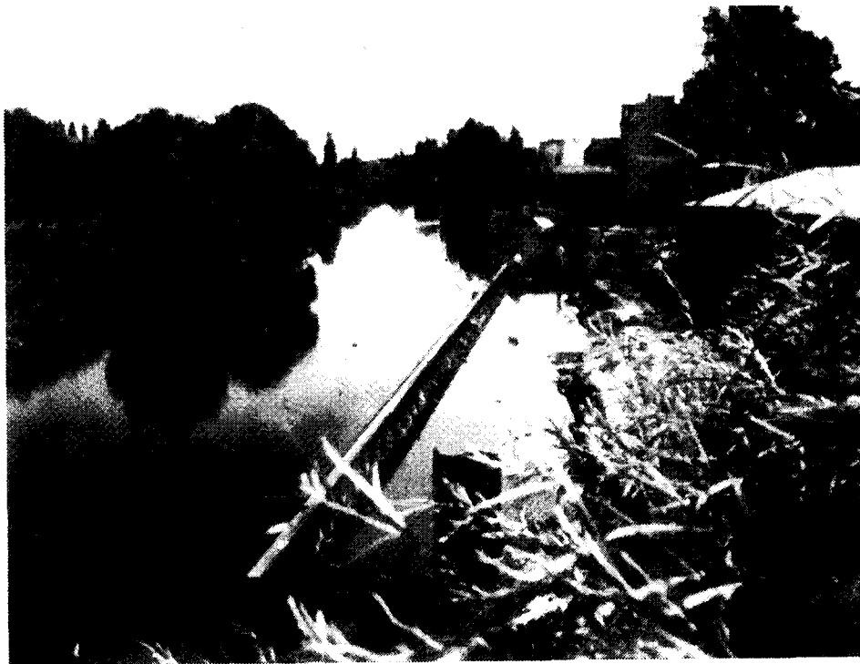
Bild 2: Sicherung des am Ernst-August-Kanal gelegenen Sanierungsgeländes.
