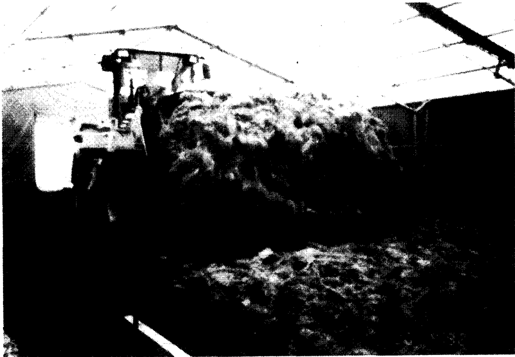
Bild 8: Verteilen des Stroh/Pilz-Substrates auf teer- ölbelastetem Boden im Mischzelt.
