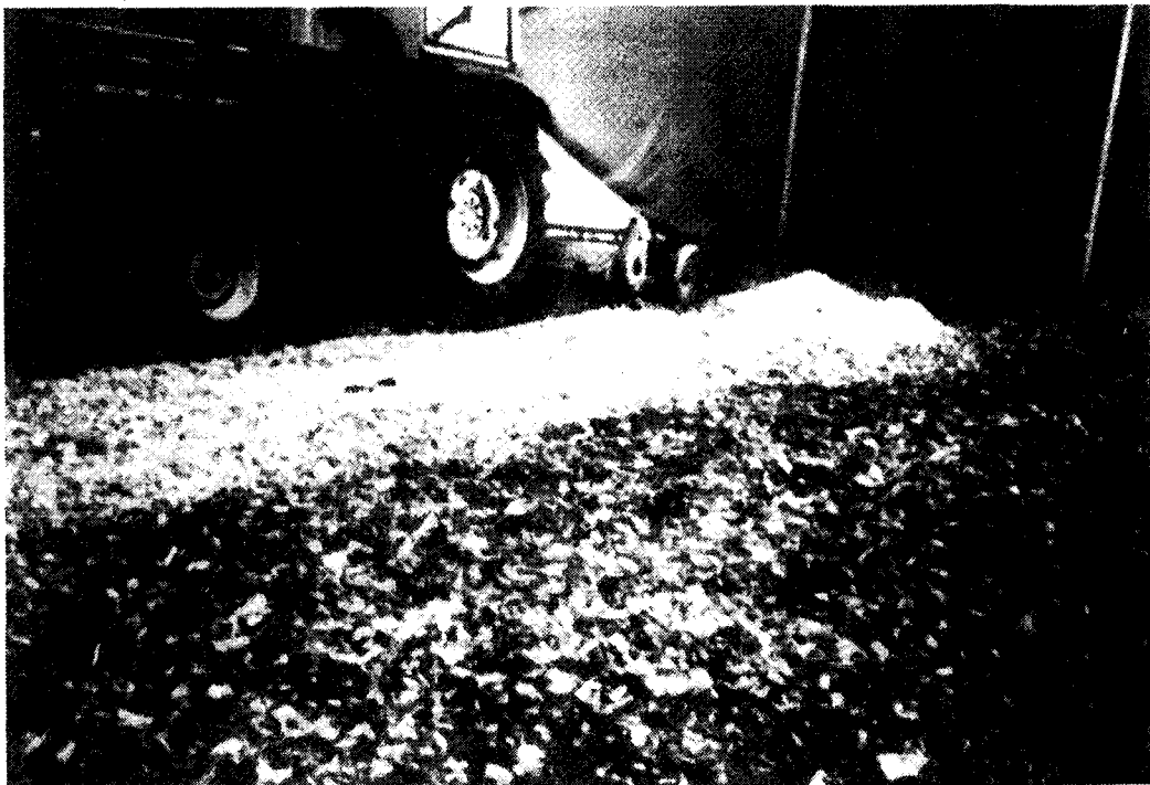
Bild 9: Einarbeitung des Substrates in den kontaminierten Boden.
