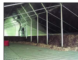
Biofilter Innenansicht
