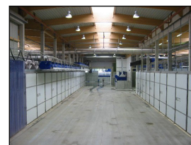
Hallenbereich mit Rottetunnel
