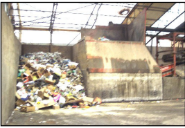
Flachbunker und Schredder
