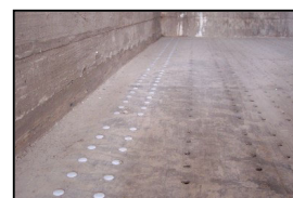
Belüftungsöffnungen Intensivrotteboxen
