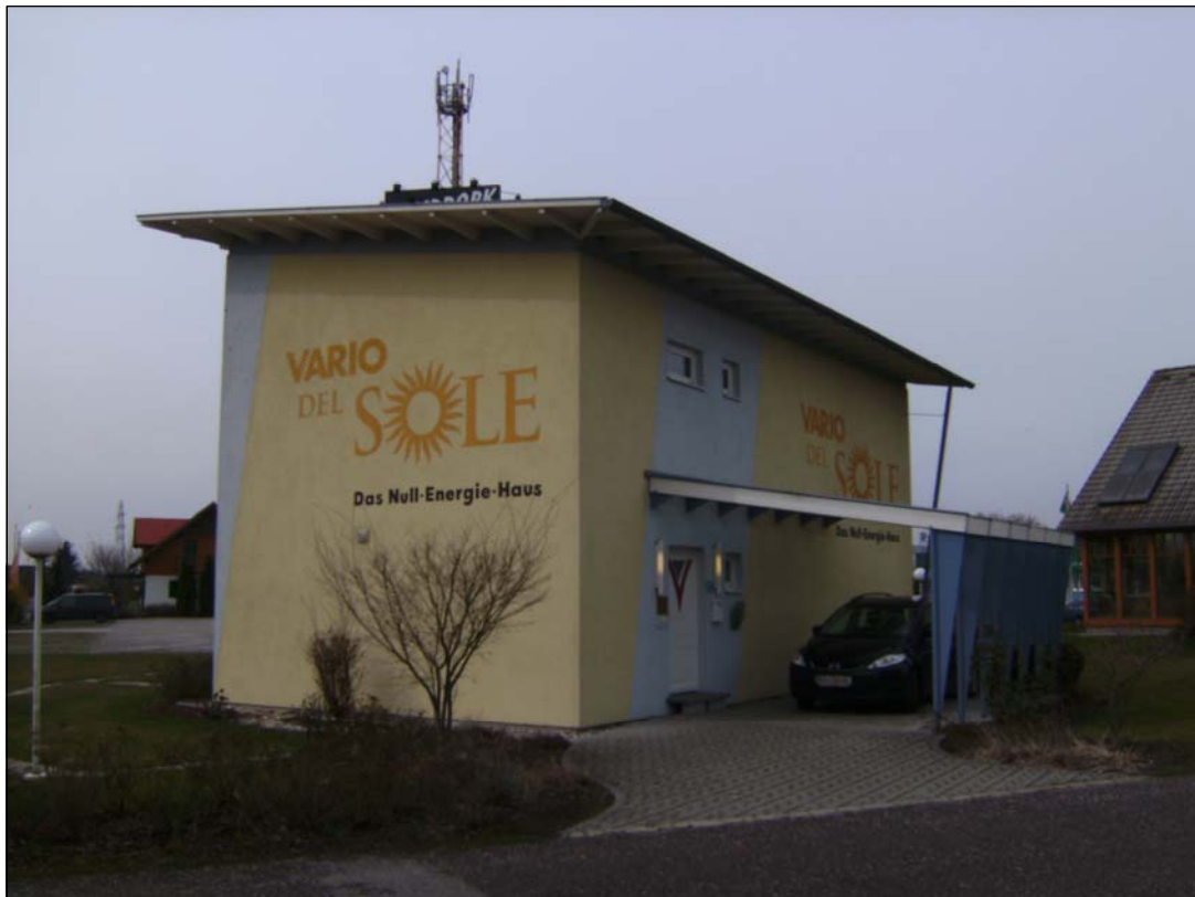
Abbildung 15: Gebäude 6 – Ansicht von Immissionspunkt 7
