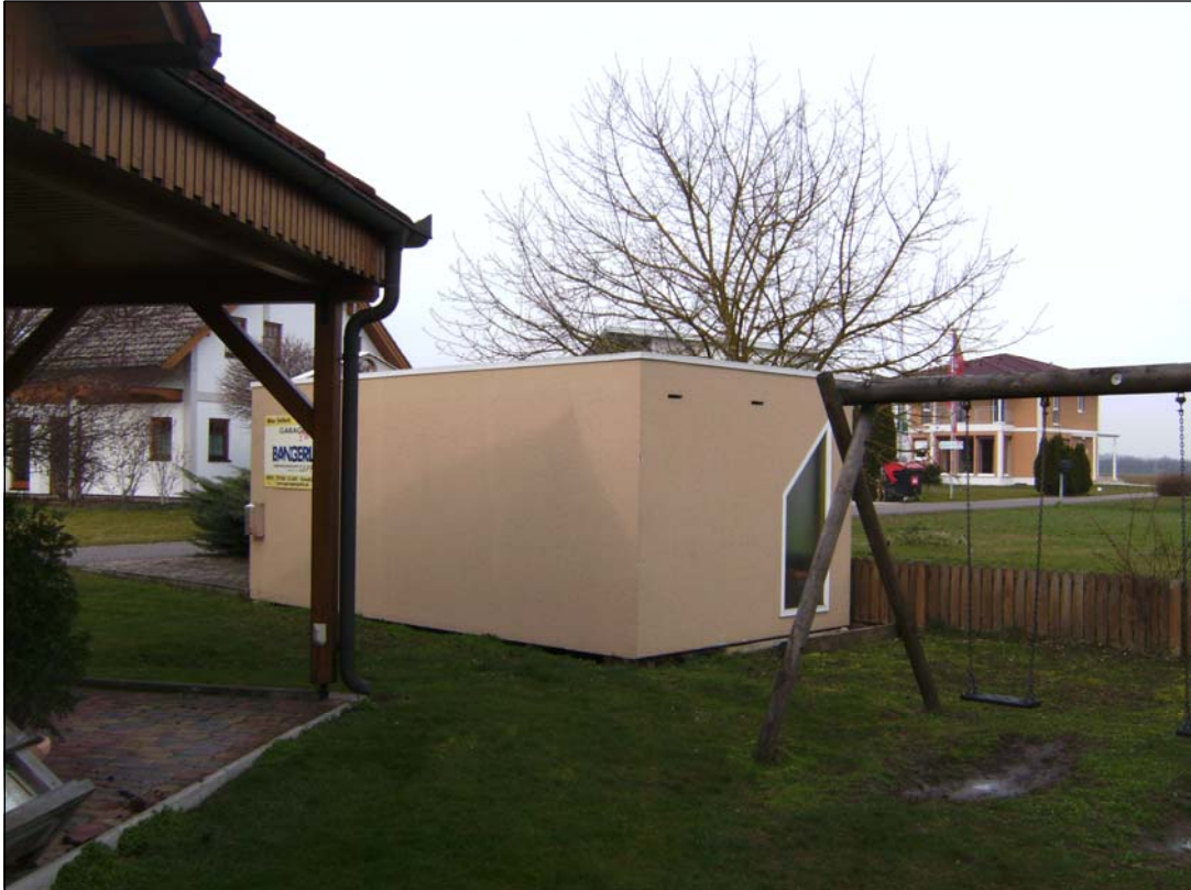
Abbildung 9: Garage – Ansicht aus Ost
