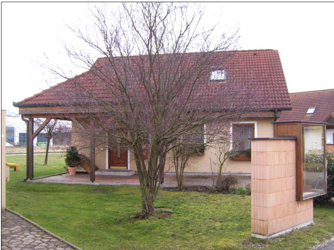
Abbildung 10: Gebäude 1 – Westansicht (das rechte Fenster ist schallabstrahlend - offen!)
