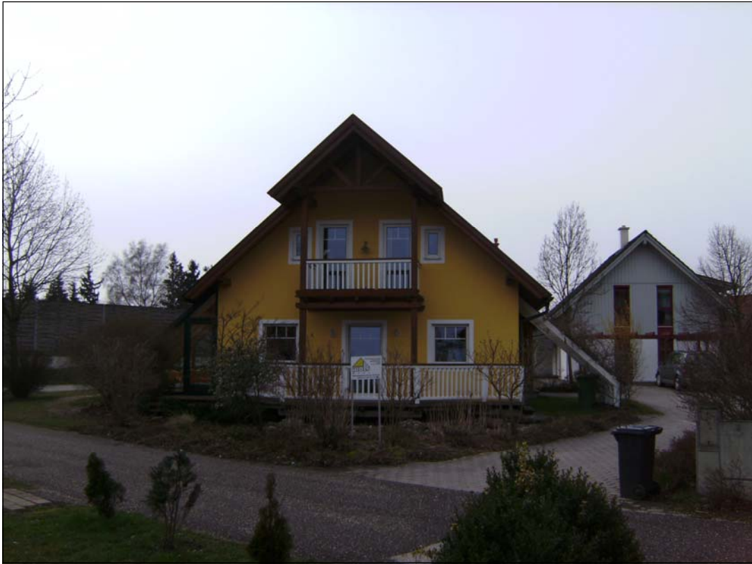
Abbildung 13: Gebäude 3 – Ansicht von Immissionspunkt 7, dahinter Gebäude 4
