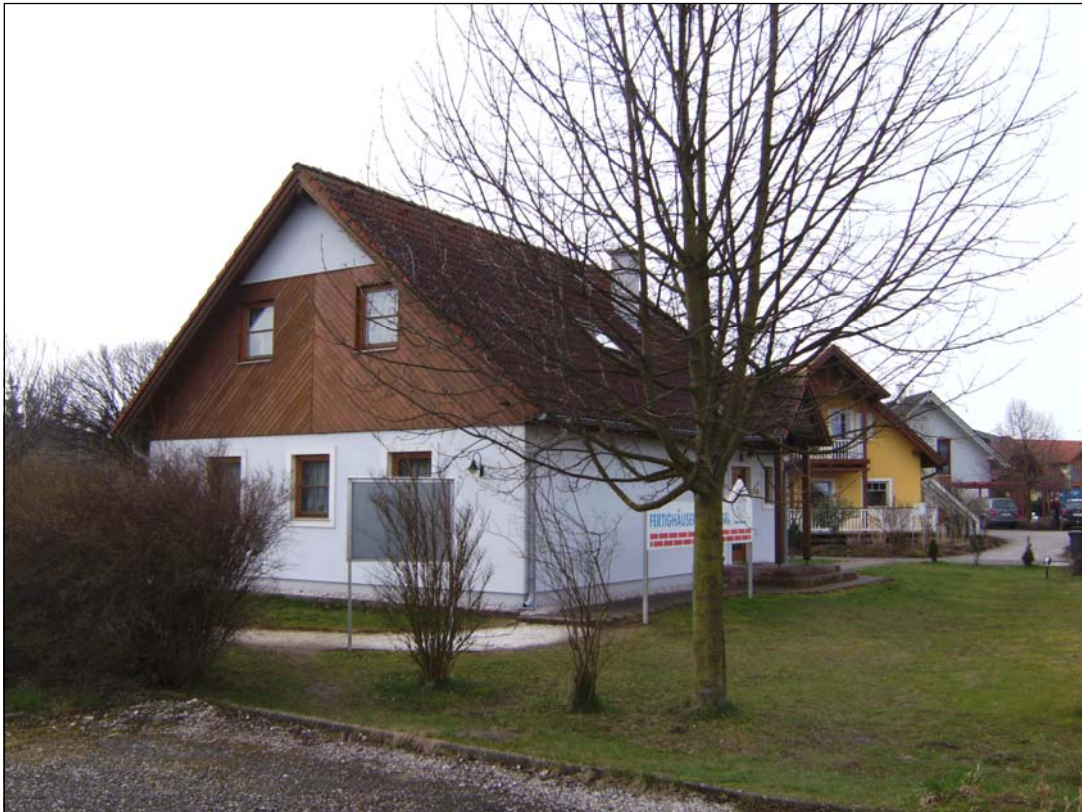
Abbildung 5: Gebäude 2 – Ansicht von Norden
