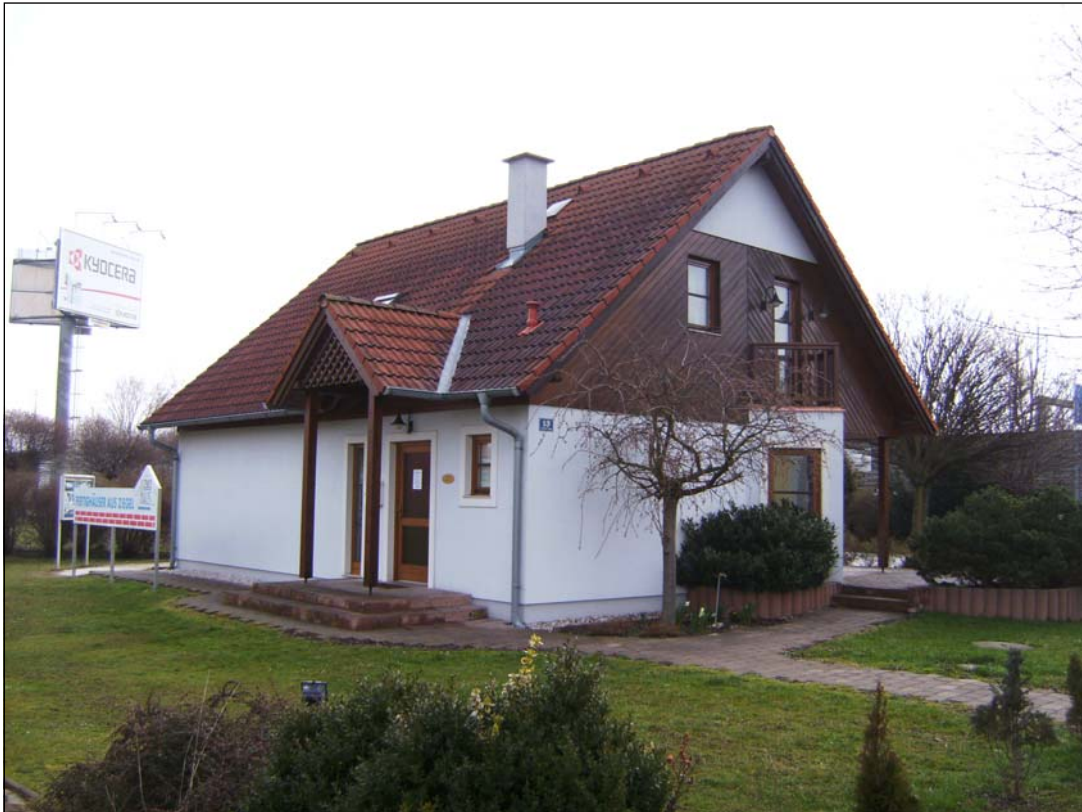
Abbildung 3: Gebäude 2 – Ansicht von Westen
