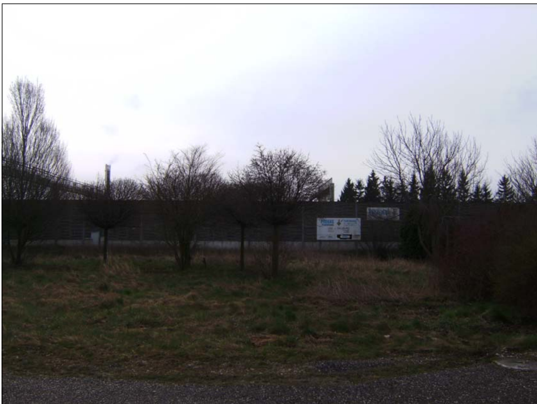
Abbildung 6: Lärmschutzwand der A1, Ansicht von Immissionspunkt 9
