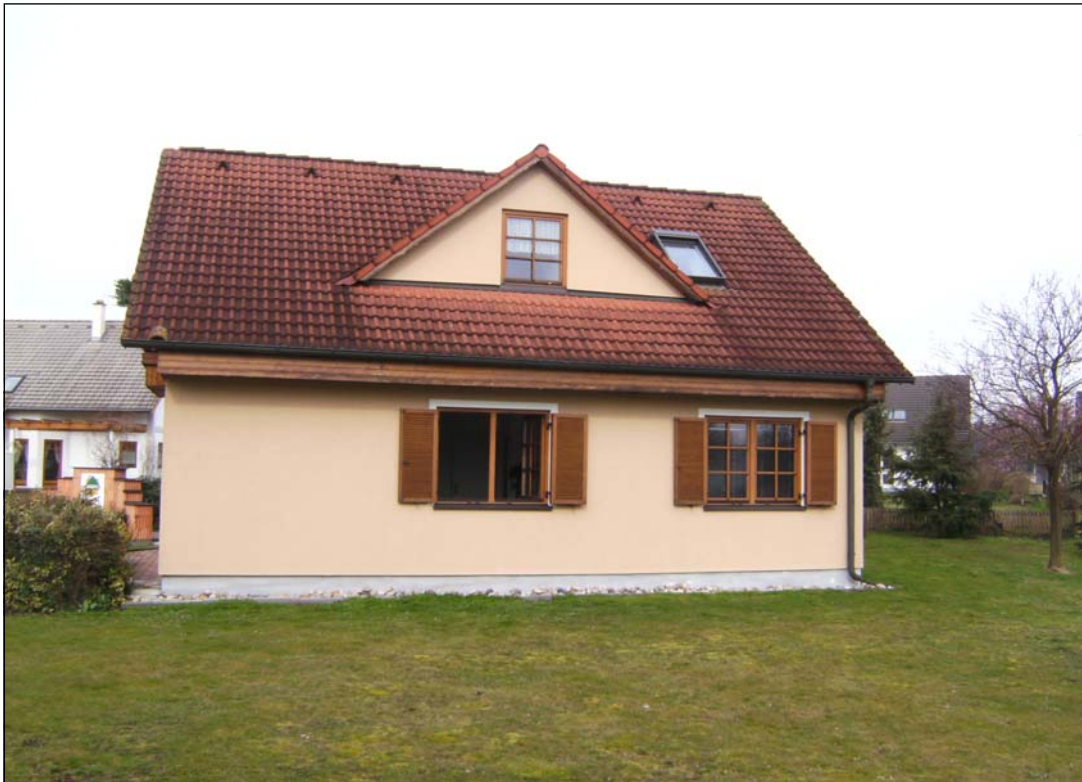
Abbildung 4: Gebäude 1 – Ostansicht (das geöffnete Fenster ist schallabstrahlend!)
