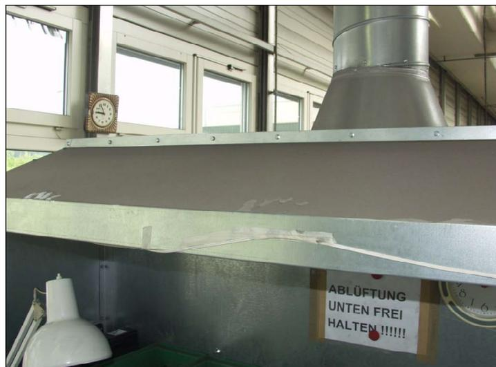
Abbildung 14: Arbeitsplatzabsaugung am Demontagearbeitsplatz (Quelle: EMPA, 2011).
