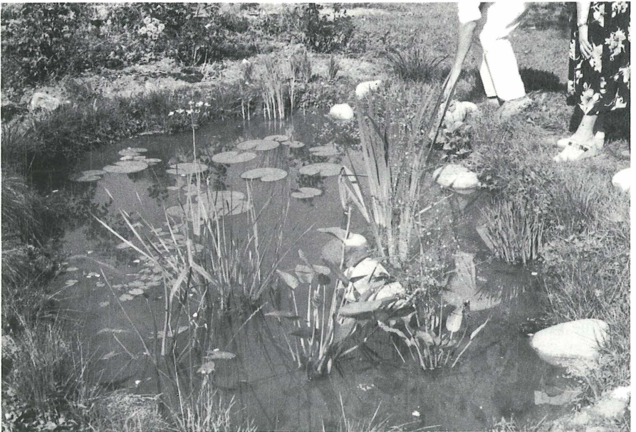
Abb. 2: Folienteich mit erkennbarer Zonenunterteilung in der Bauphase und kurz nach der Bepflanzung (Wasserfläche ca. 15 m 2 )
