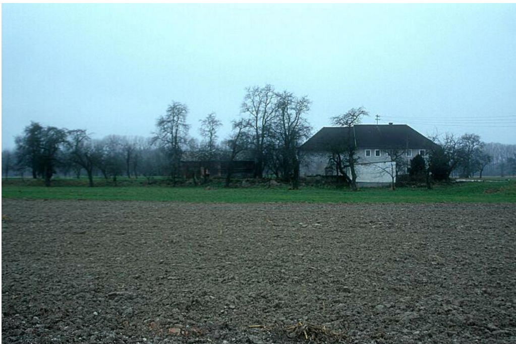
004, 004a Gehöft mit idealem, halb offenem, teilweise gemauertem Nebengebäude und Streuobstbestand.
