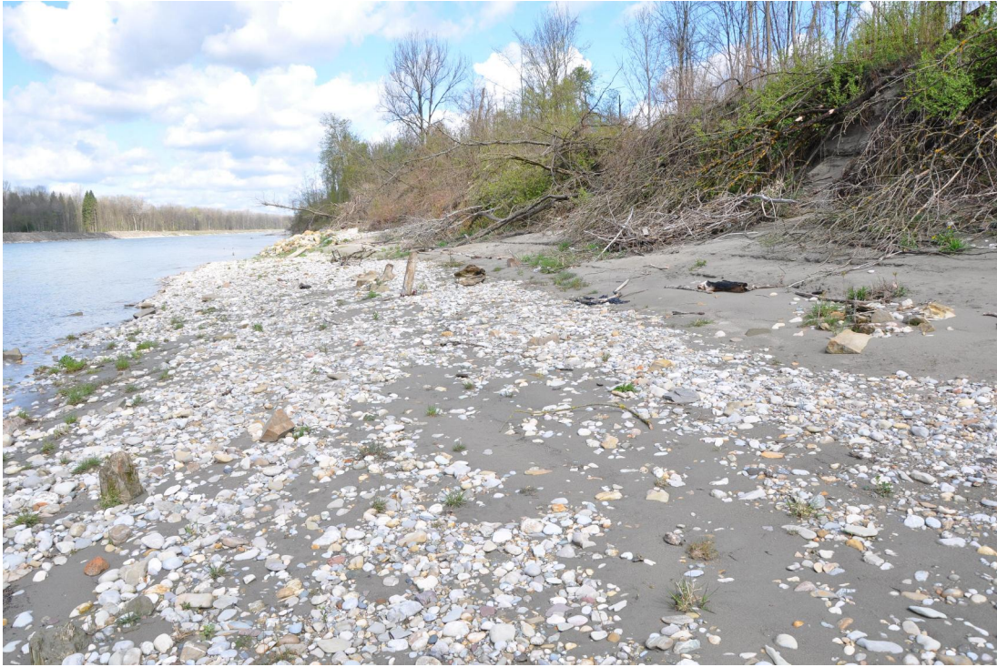
Foto 1: Weiche Ufer flussab der Sohlrampe bei Flkm 51,9 (Foto Eisner 11.02.2012)
