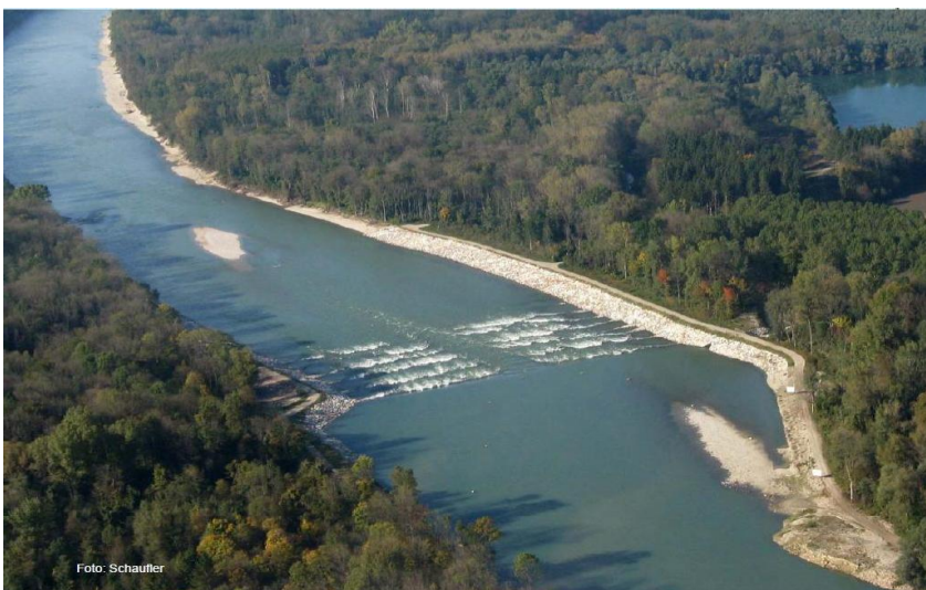
Abbildung 19: Sohlrampe bei Flkm 51,9 mit anschließender Entfernung der Ufersicherung (weiche Ufer)
