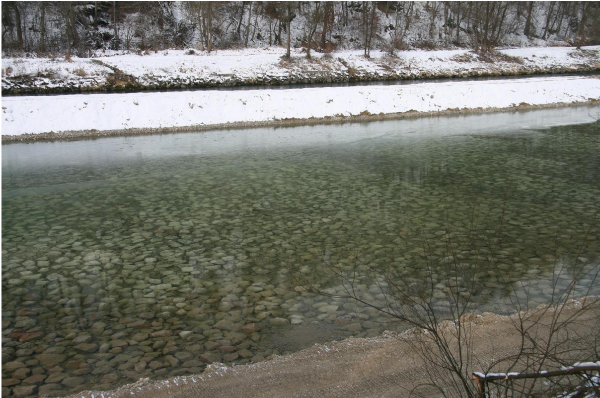
Abbildung 20: offenes Deckwerk, Einbau bei Laufen (Schaufler, 2008)
