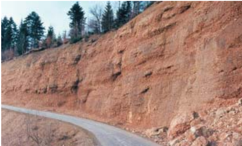
Abb. 7: Sandstein-Mergel-Wechsellagerung in der Weissachschichten an der Bödelestraße
