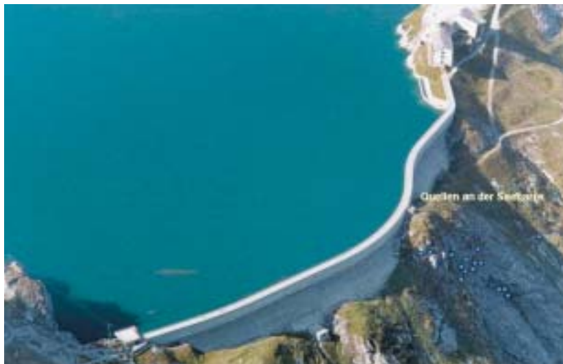
Abb. 4: Staumauer Lünensee, Quellen an der Seebarre
