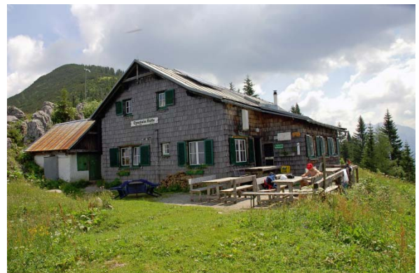
Die „Ennstalerhütte“ im Gesäuse
