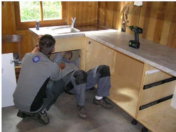
Montieren des neuen Küchenblocks
