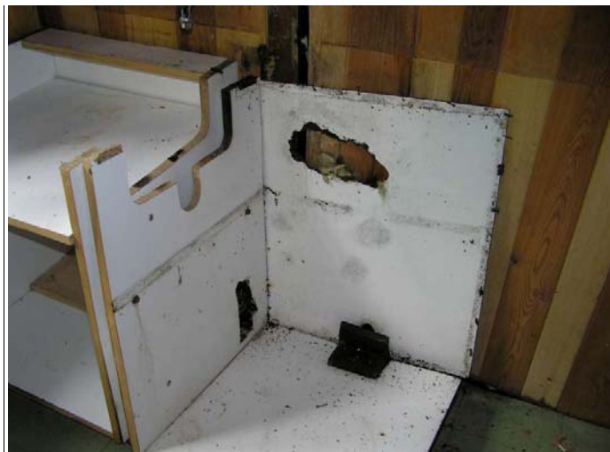
Demontage der alten Küchenzeile
