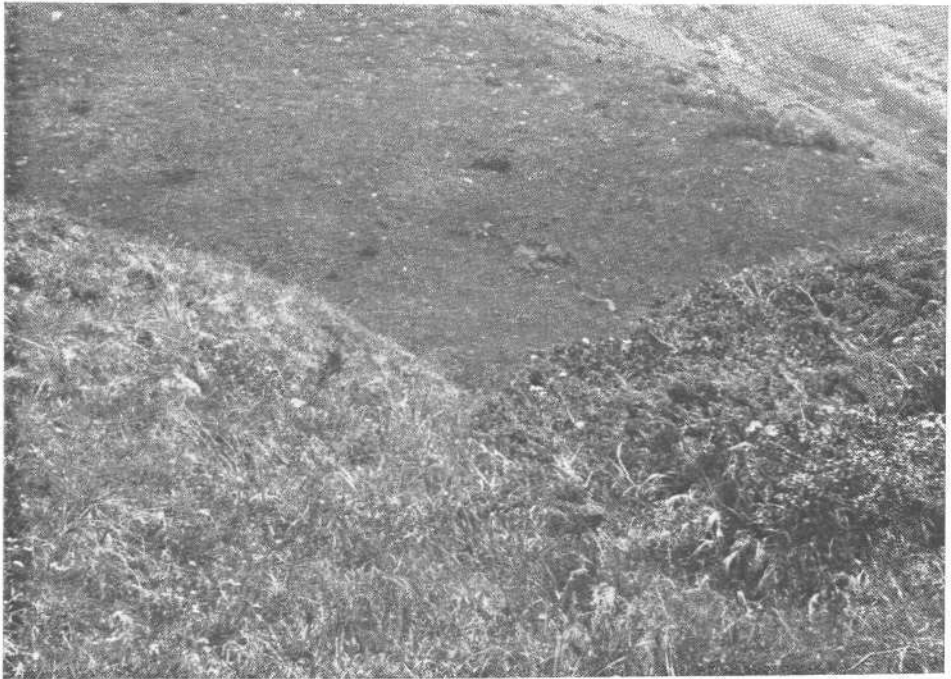
Abb. 6: Zerreißgraben inmitten des Rutschhanges
