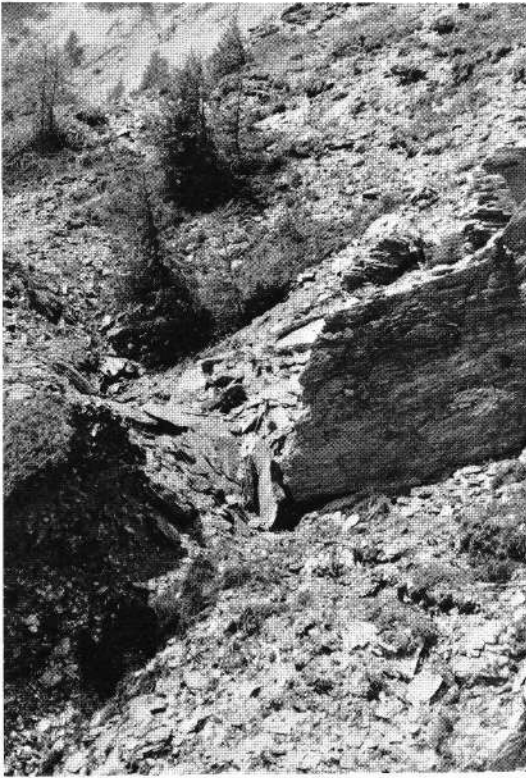
Abb. 14: Teilweise ist ein Zerbrecchen und Zergleiten des hochteilbeweglichen Phyllitverbandes in eine Schutthalde zu beobachten.
