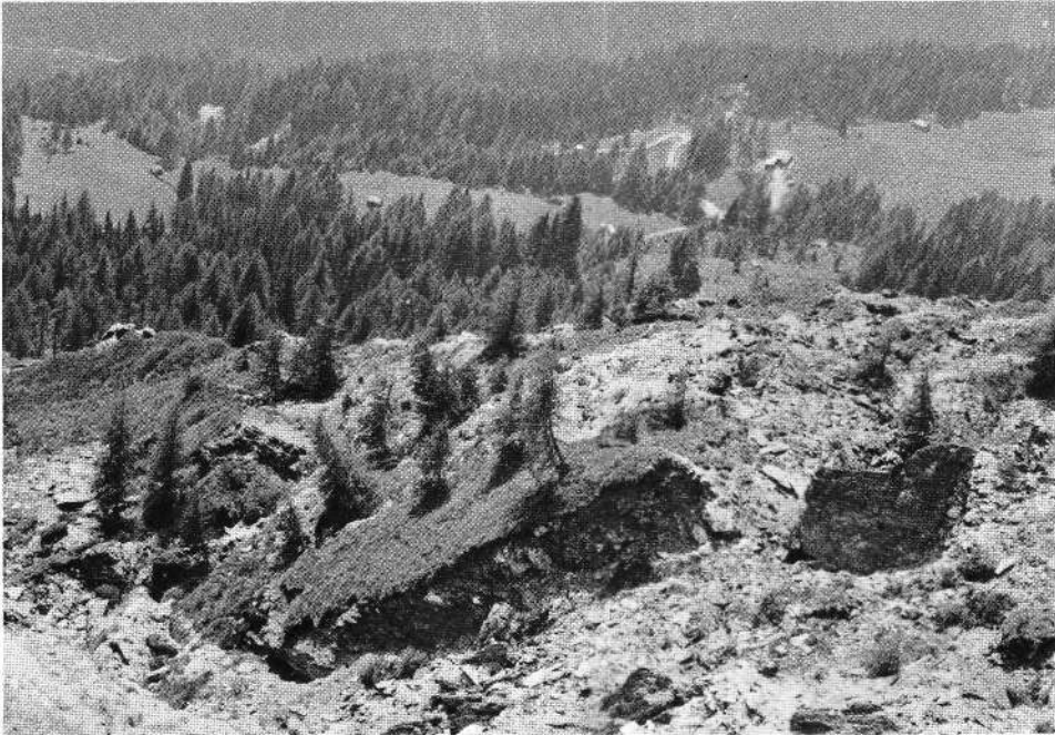
Abb. 13: Blick von der Hauptabrißkante in 2000 m Sh auf den oberen Teil der Talzuschubsmasse, der sich bedingt durch die starke Hangbewegung in ein Schollenmosaik aufgelöst hat.
