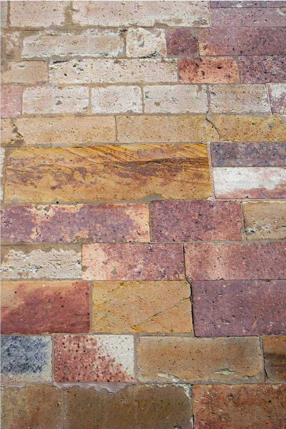
Abb. 1 Farblich unterschiedliche Varietäten von Zeisigwald-Tuff im Mauerwerk der Chemnitzer Schlosskirche.
