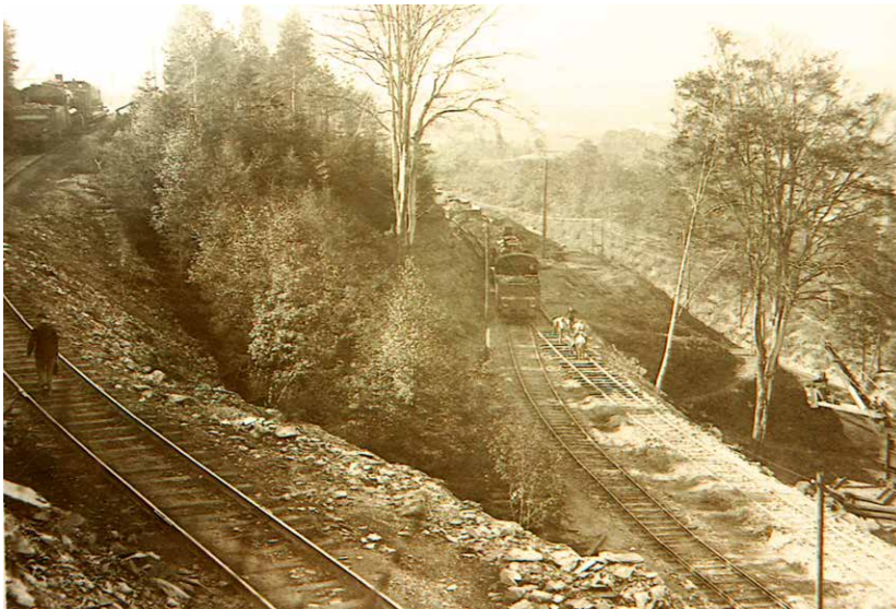
Abb. 15 | Trassenführung zu Abbaubeginn (Archiv M. Glöckner).
