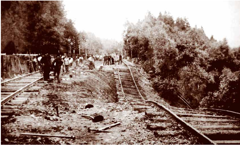
Abb. 14 | Abrutschen der flusseitigen Trasse zu Beginn der Bauarbeiten (Archiv M. Glöckner).
