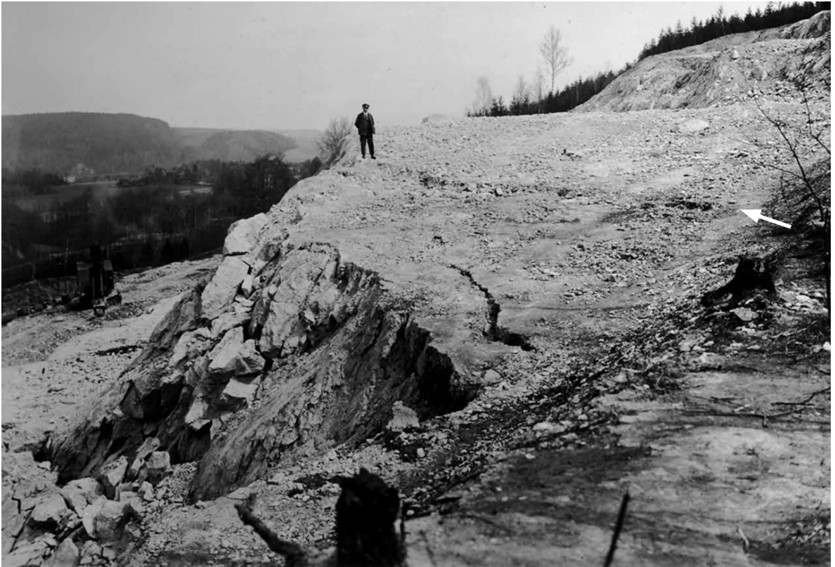
Abb. 22 | Blick vom oberen Westrand der Baustelle nach Osten. Der Herr steht an einer nach Herstellung des Planums erfolgten Rutschung, die nach der Mitte des rechten Bildrandes verläuft (Pfeil). Foto K. Pietzsch am 22. April 1932 (Archiv LfULG).
