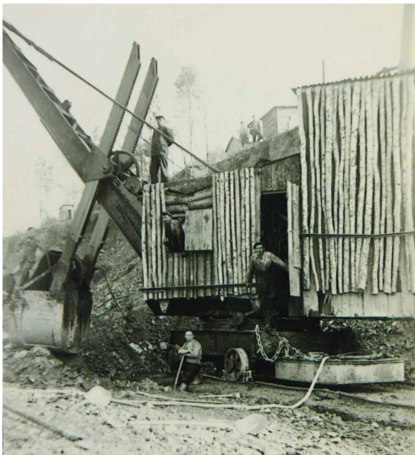
Abb. 17 | Dampfbagger mit Baggerführer Richard Weid (Archiv M. Glöckner).
