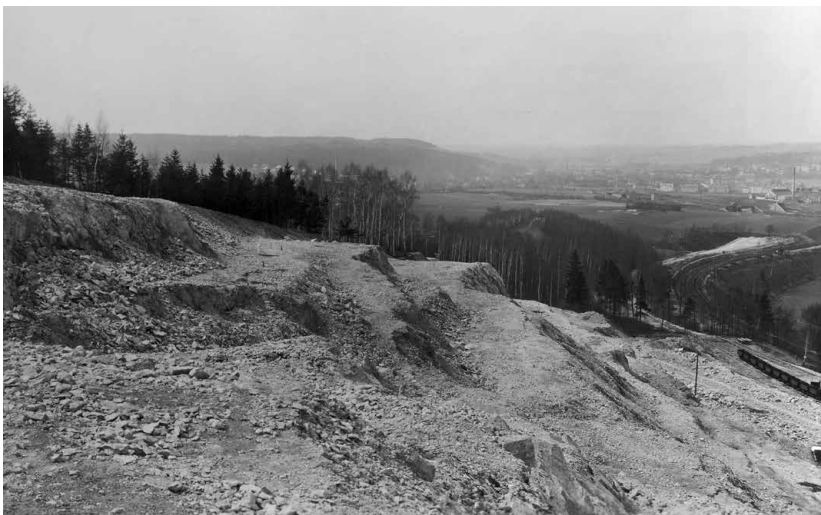
Abb. 21 | Blick vom oberen östlichen Rand der Baustelle nach Westen. Erkennbar sind nachträgliche untergeordnete Rutschungen am oberen Hangabschnitt. Foto K. Pietzsch am 22. April 1932 (Archiv LfULG).
