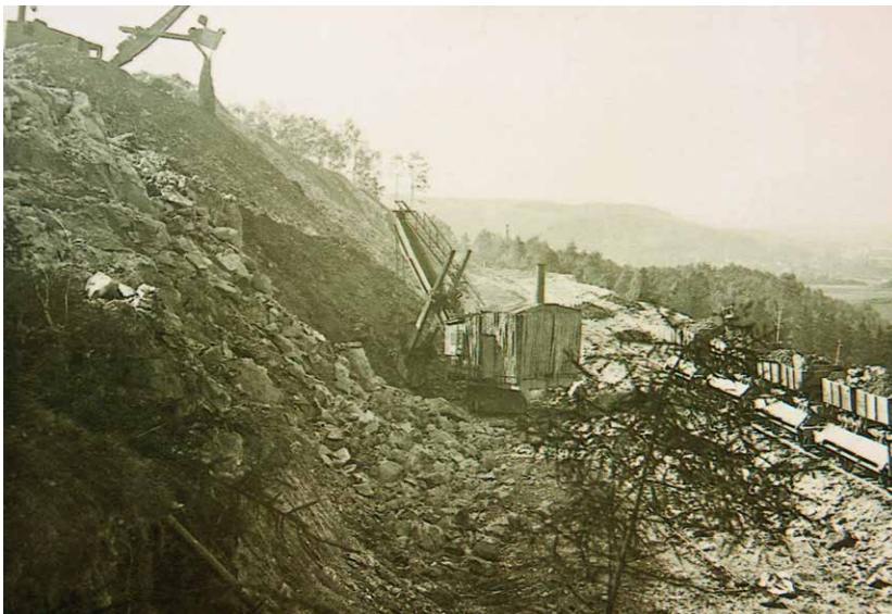
Abb. 16 | Hangabtrag mit dampfbetriebenenem Löffelbagger (Archiv M. Glöckner).
