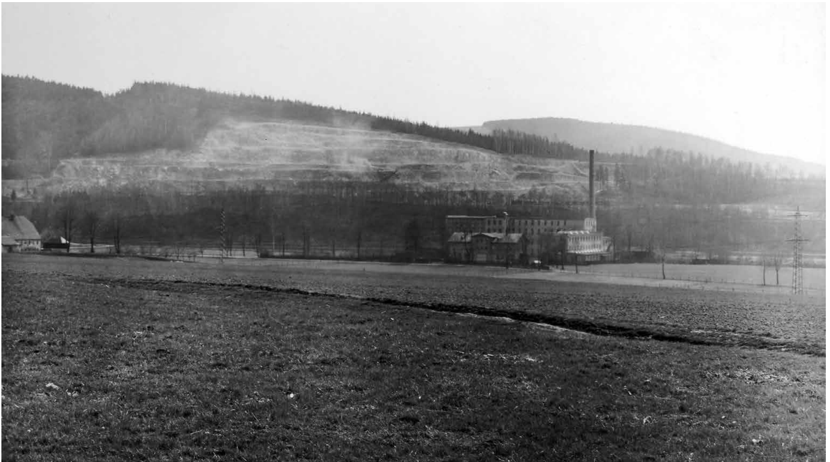
Abb. 23 | Blick vom Punkt 300,4 an der Staatsstraße zwischen Gückelsberg und Falkenau auf die Baustelle. Foto K. Pietzsch am 22. April 1932 (Archiv LfULG).
