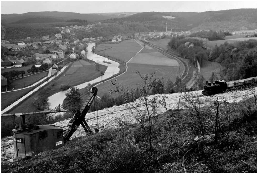
Abb. 19 | Abtragungsarbeiten mit Löffelbagger und Bauzug. Foto A. Köhler, Freiberg, vermutlich 1931 (Archiv LfULG).
