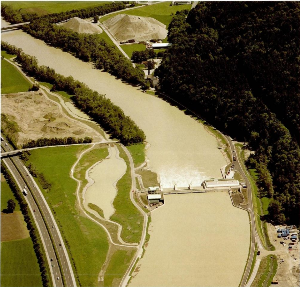
Abb. 1: Kufsteiner (rechtsseitig) und Langkampfener (linksseitig) Innauen (im linken oberen Bild Drittel). Im Vordergrund das TIWAG-Kraftwerk Langkampfen (Foto: TIWAG)
