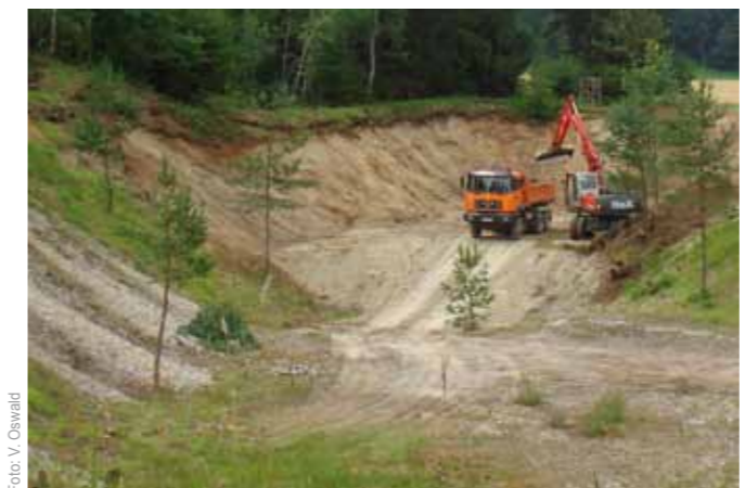
Beginn der Maßnahme im Jahr 2007: der humose Oberboden wird abgetragen
