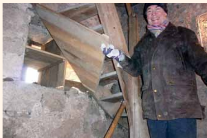
Prof. Förderreuther freut sich über den gelungenen Einbau der Dohlenkästen, die den Bestand in Steinhöring langfristig sichern helfen
