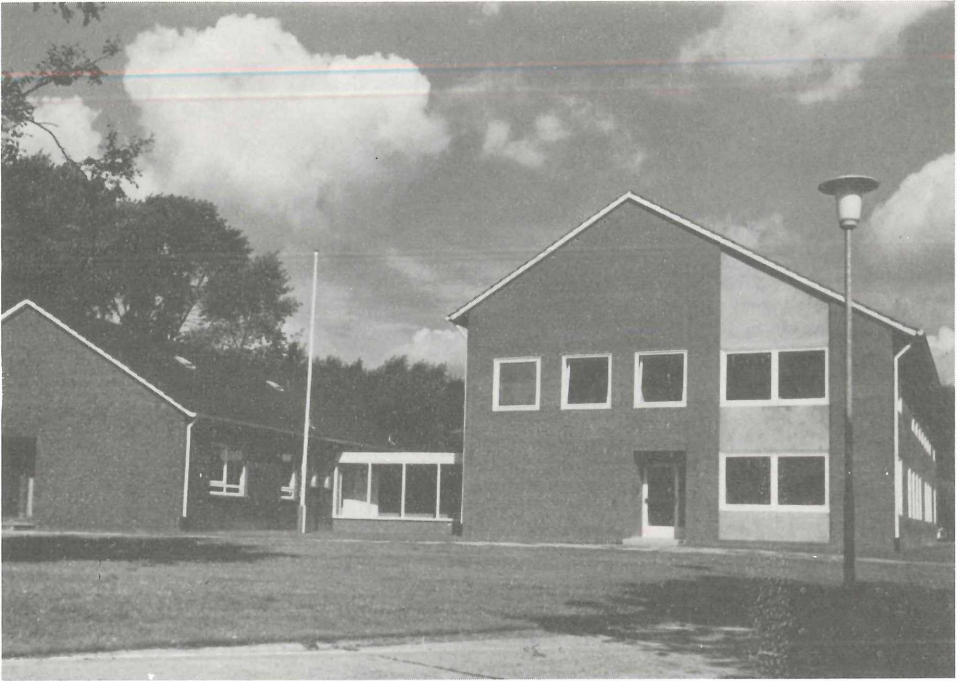
Abb. 4. Werkstattgebäude (links), durch Glasgang verbunden mit dem Hauptgebäude, von Südosten.
