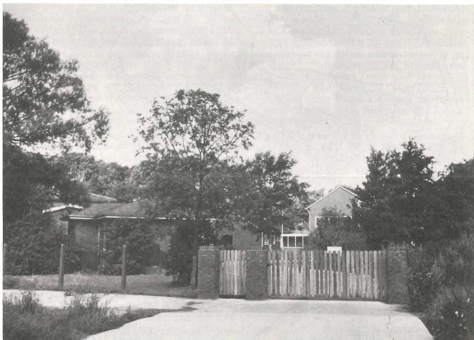
Abb. 2. Haupteingang, von links nach rechts Garten-(Gemeinschafts-)Häuschen, Hörsaalgebäude, Werkstattgebäude und Hauptgebäude im Hintergrund. Alle Aufnahmen: H. Rittinghaus.
