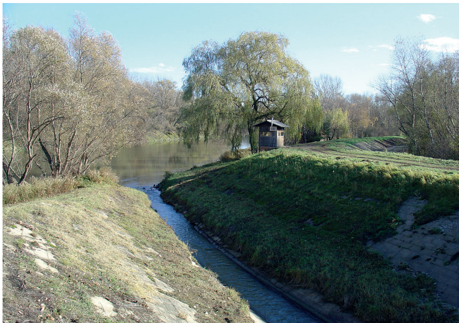
Abb.4: Mündung des Weidenbaches in die March vor der Renaturierung (Foto aus LAND UND WASSER 2008)
