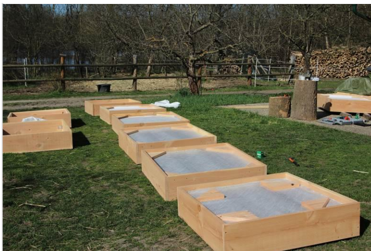
Abbildung 2: Die einzelnen Module des Brutfloßes mit den Schwimmkörpern, die mit Vließ abgedeckt und mittels Holzwinkel stabilisiert werden.
