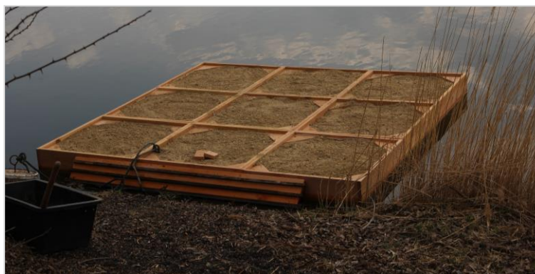
Abbildung 3: Die einzelnen Module werden miteinander verbunden und darauf eine dünne Schotterschicht aufgebracht.
