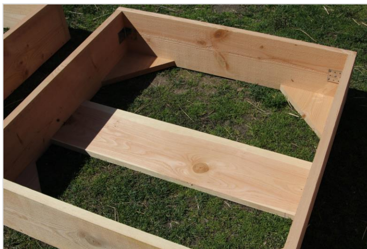
Abbildung 1: Rahmenkonstruktion eines Moduls des Brutfloßes.
