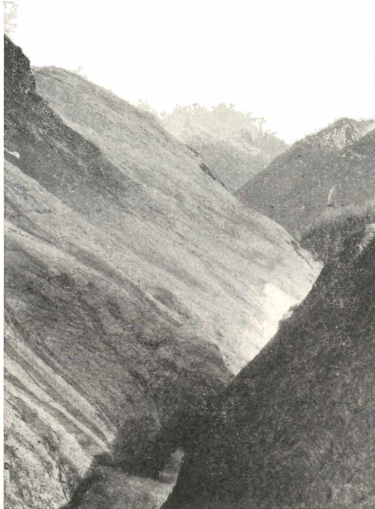
Abb. 3. Mölltal unterhalb Möll-Sperre des Speichers Magaritze. Blick von der Sperrenmauer in die Schlucht. Flußkilometer 75,5 23. Mai 1960.
