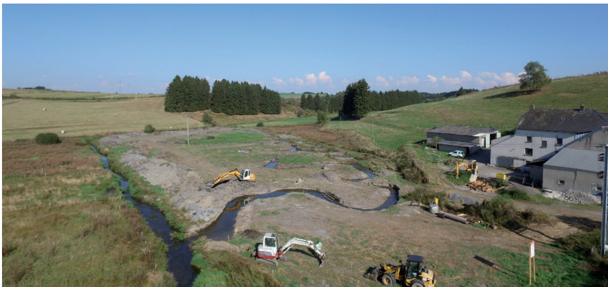
Fig. 1: At the “Leresmühle” site, in the North of Luxembourg, the “Trëtterbaach” was restored along a section of 380m. The stream was taken out of its artificial bed – an old mill channel - and returned into the natural floodplain. - Flussrenaturierung an der “Trëtterbaach”. An der “Leresmühle”, im Norden Luxemburgs, wurde die “Trëtterbaach” auf einer Länge von 380m renaturiert. Dabei wurde der Bach aus dem künstlichen Mühlenkanal herausgenommen und in sein natürliches Flussbett zurückgeführt (Photo: © natur&ëmwelt).
