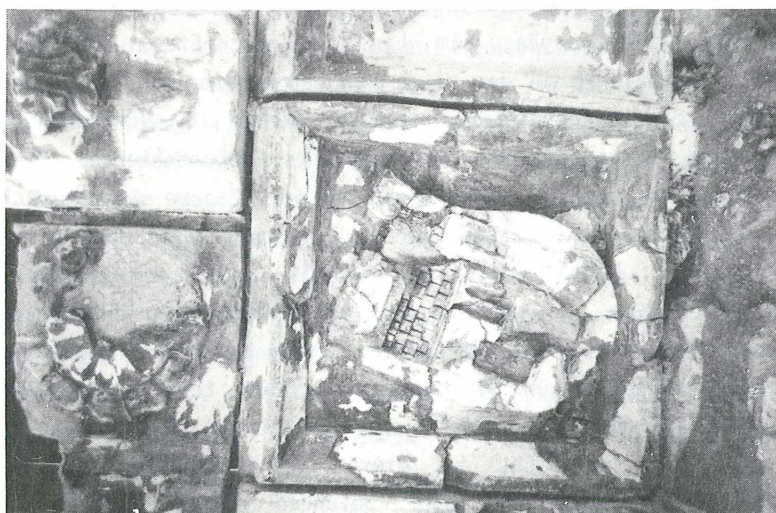
Abb. 10: Terrakotta-Maßwerkemporenbrüstung. Mittelteil mit den Wappen des Stifterpaares während der Restaurierung, August 1983.
