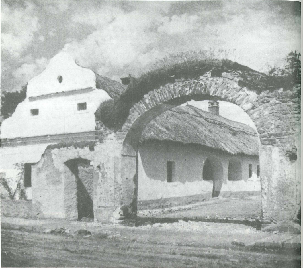
Abb. 3: Das Kernács (Izsó)-Haus mit Arkadenflur und Parapet. Baujahr: 1821. Das Foto von Kálmán Tóth stammt aus dem Jahre 1936, seither wurde der rechte Bogen zugemauert. Kővágó-örs, Petőfi-Str. 18.
