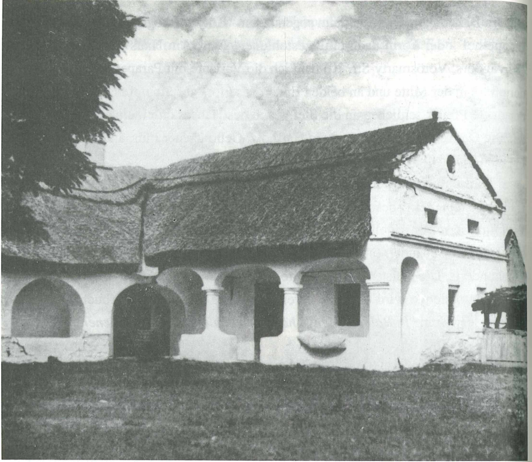
Abb. 4. Das Tobak- oder Vicsispán-Haus mit Arkadenflur in Kövágóörs. Das Foto von Kálmán Tóth stammt aus dem Jahre 1936, das Haus wurde in den 1950er Jahren abgerissen.
