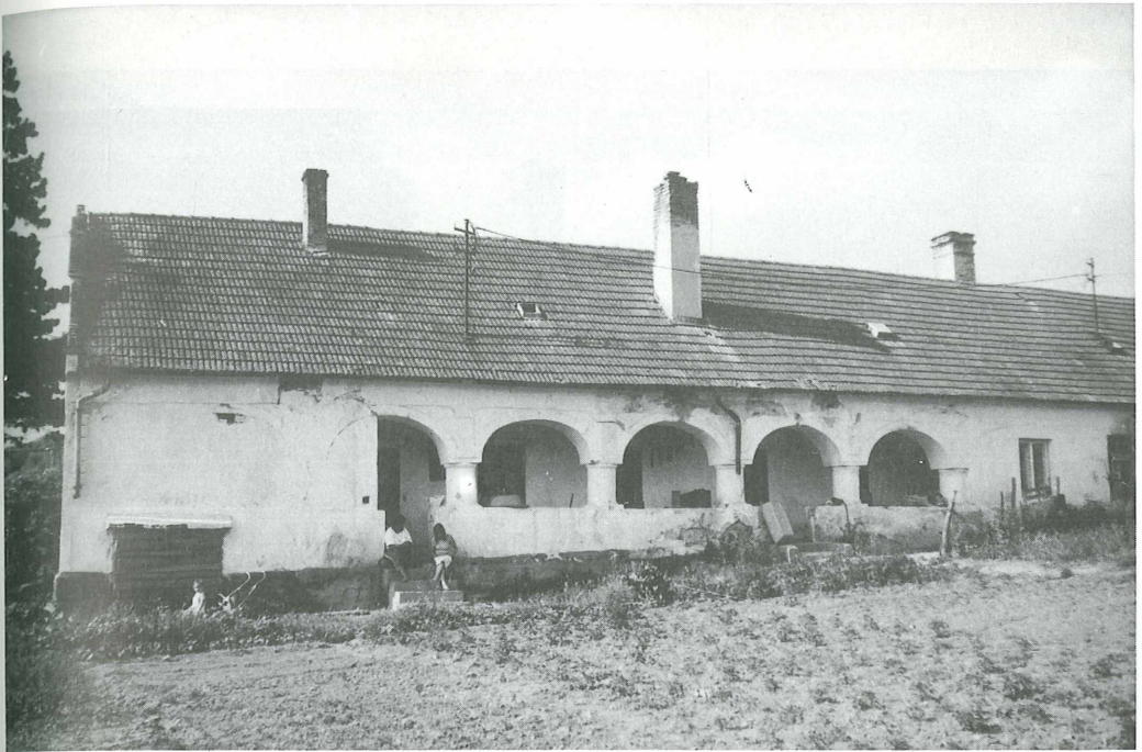
Abb. 6: Säulenflur des Balogh-Hauses (Baujahr 1856), Arkadenreihe mit Korbbogen und Parapet. Die Arkadenreihe bestand ursprünglich aus sechs Bögen, davon wurde der erste Bogen vollständig, der zweite zur Hälfte zugemauert. Balatonhenye, Kossuth-Str. 45. Foto: Lukács, 1985.
