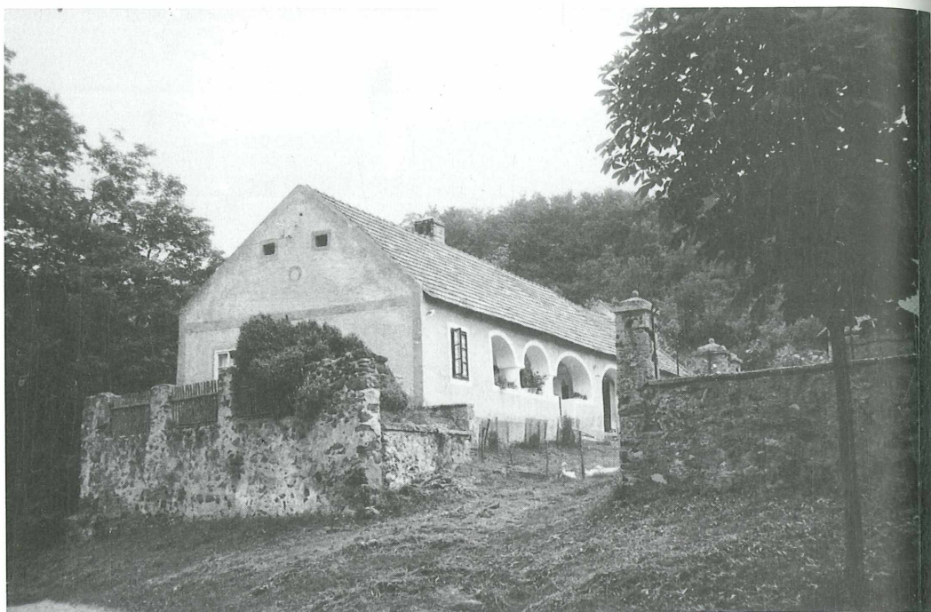
Abb. 9: Die Arkadenreihe am Säulenflur des Kenessey-Hauses (Baujahr 1844) besteht aus drei Bögen. Vom Vorderteil des Flurs wurde in den 1940er Jahren eine Speisekammer abgetrennt. Balatonhenye, Kossuth-Str.125. Foto: Lukács, 1985.
