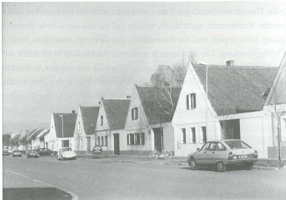
Abb. 6: Illmitz, Angergasse. Siedlung der Wohn- und Siedlungsgenossenschaft "Heimstätte", errichtet 1940. (Foto: Vera Mayer/1986)
