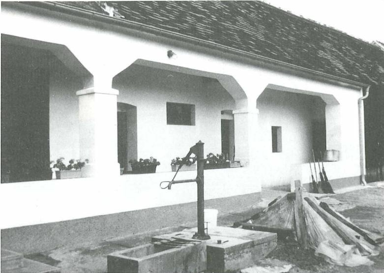
**Abb. 5: Oberwart, Laubengang um 1930.** Hier ist die Arkade bereits zu einem Durchlaufträger aus Stahlbeton mit Pilzstütze degeneriert. (Foto: Komzak)
