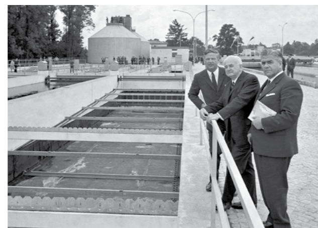
Die Kläranlage Bregenz, ein Schritt zum sauberen See (Foto: Oskar Spang 1968, Stadtarchiv Bregenz).
