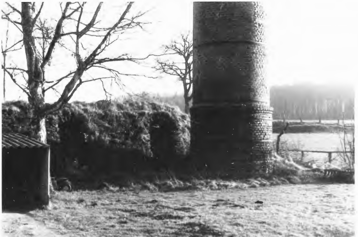
Abb.15: Detailaufnahme des Ringofens der alten Ziegelei in Lasbeck mit Eingängen zu den Brennkammern.
