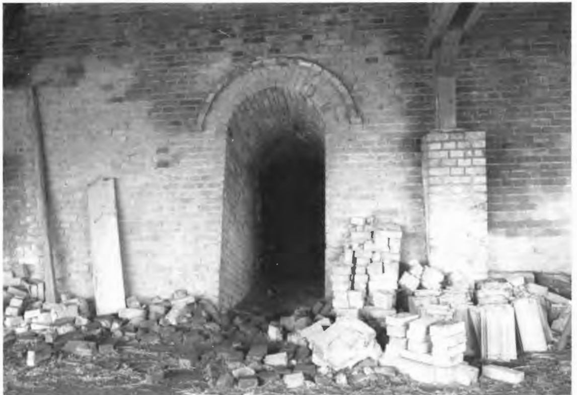
Abb.13: Außenwand des Ringofens (Nordseite) der Ziegelei Hanning mit Eingang zu einer Brennkammer.
