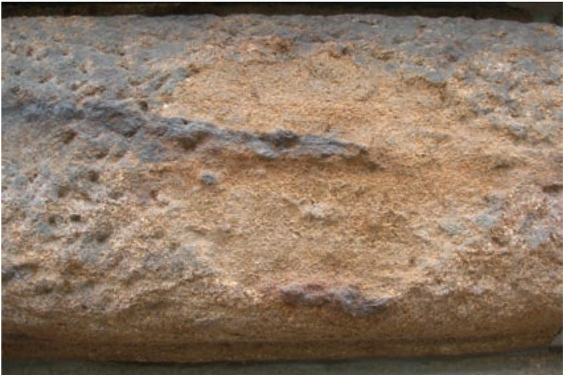
Abb. 11: Flächiger Verlust der Oberfläche durch Absanden infolge Bindemittelverlust bzw. Absanden nach Verlust der Kruste an der Oberpostdirektion in Hamburg (Foto Ebel)
