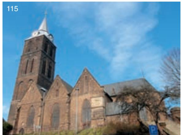
Abb. 116: Ev. Kirche St. Andreas in Lübbecke mit großen Maßwerkfenstern auf der Nordseite der gotisch erweiterten romanischen Kirche (1350). Die Fensterlaibungen sowie ein Teil der Stützpfeiler sind mit Porta-Sandstein erbaut worden. Das Mauerwerk besteht überwiegend aus einem feingeschichteten Kimmeridge-Sandstein, der in einem heute noch zugänglichen Steinbruch – unweit der Kirche – abgebaut wurde. Der Porta-Sandstein dürfte am Jakobsberg gebrochen worden sein.
