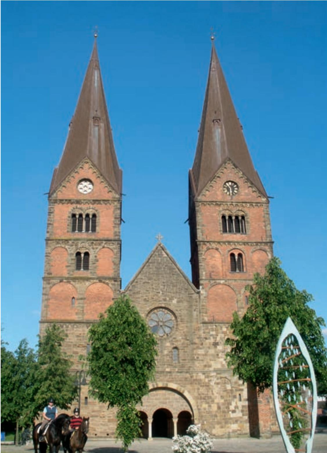
Abb. 56: Stiftskirche in Bücken; Nordseite der Kirche mit romanischer Fassade, die mehrere Rundbogenfriese aufweist; 1863-1868 Sanierung der fast baufällig gewordenen Kirche, Steinersatz mit hellem Sandsteinmaterial (vermutlich Obernkirchener Sandstein)
