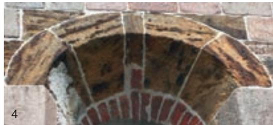
Abb. 1: Große Werkstein-Flächen am Kaiser-Wilhelm-Denkmal (Porta Westfalica): gut sichtbar die wechselnden Farbbereiche von grau über gelb bis rostbraun in Abhängigkeit von der Verteilung des Eisenhydroxids im Gestein und die Erz-artigen Anreicherungen der Eisenhydroxide und -oxide in Form von Schwarten, Lagen, Flecken (Foto Ehling)
