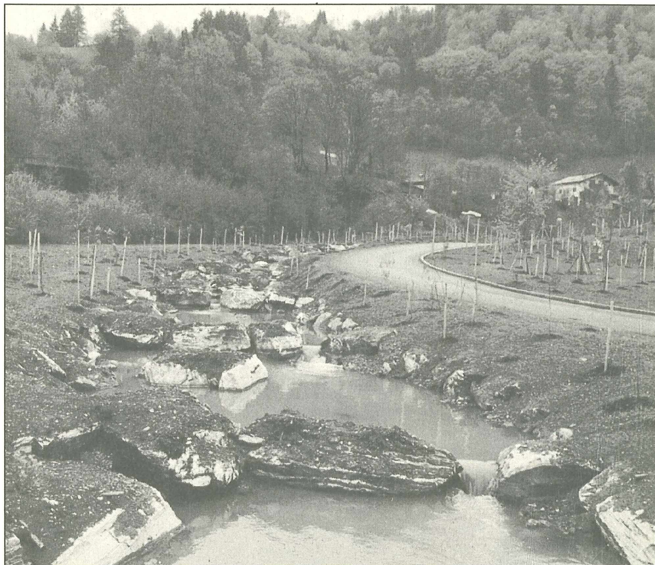
Fischstufe beim Salzach-Kraftwerk St. Johann,
