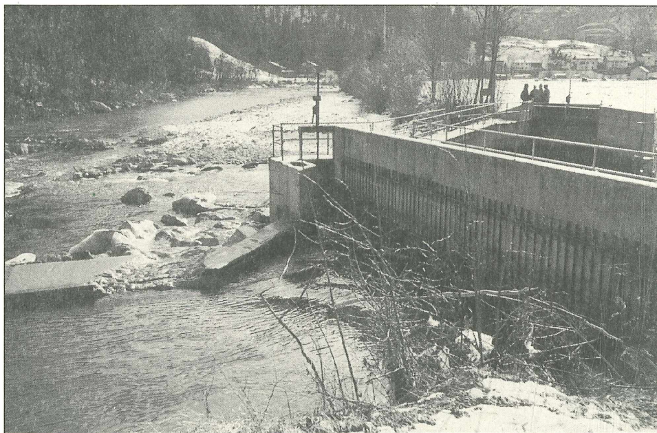
Nicht funktionierende, trockenliegende „Fischtreppe“ beim Huber-Wehr an der Lammer/Salzburg. Foto: H. Augustin
