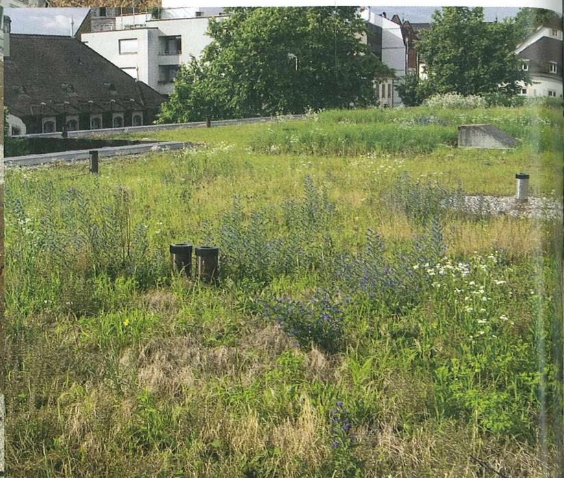
**Bilder 2-3: Naturnah eingerichtete Dachbegrünung in Basel links direkt nach dem Anlegen mit unterschiedlichen Bodensubstraten, rechts nach 4 Jahren: Eine artenreiche Dachwiese hat sich entwickelt.**
