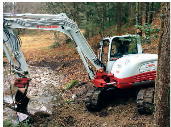
Tümpelbaggerung in Bludesch-Holzried
