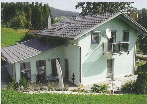
Haslach: Exklusives Haus mit moderner offener Bauweise, Fertigstellung 2002, nicht einsehbar, große Sonnenterrasse, Bushaltestelle in der Nähe. Wfl. ca. 95 m 2 , Gfl. ca. 1.117 m 2 , KP € 189.000,- inkl. Inventar. s REAL Rohrbach 07289/8505/295 Renate Hinterhölzl
