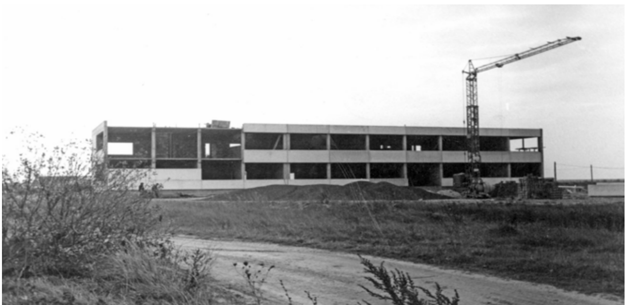
Der Bau des Nordtrakts 1970/1971
