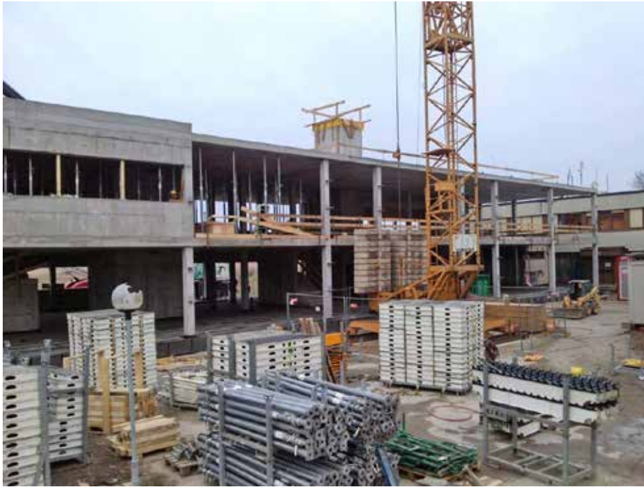
Der Neubau wurde auf Teilen der Fundamentplatte und des Parkplatzes der alten Station errichtet, am rechten Bildrand ist der noch in Betrieb stehende Nordtrakt mit aufrechter Laborfunktion bis Sommer 2015 erkennbar.
