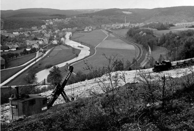
**Abb. 19** | Abtragungsarbeiten mit Löffelbagger und Bauzug.
