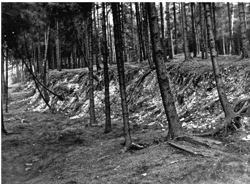
**Abb. 9** | 2 Meter tiefe Geländestufe im Hang oberhalb der Bahntrasse, verursacht durch den Bergrutsch. Foto A. Köhler, Freiberg, vermutlich 1931 (Archiv LfULG).
