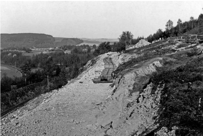
**Abb. 20** | Schienenverlegung auf einer Abbaustrosse für die Abtragungsarbeiten.
