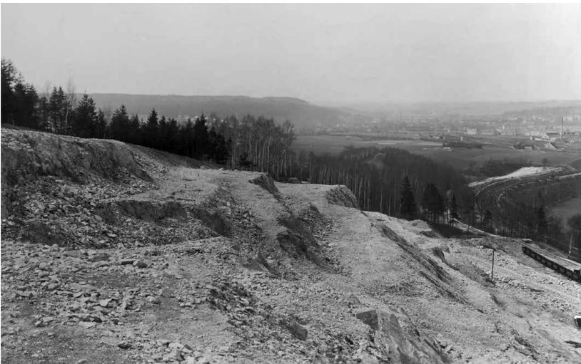
**Abb. 21** | Blick vom oberen östlichen Rand der Baustelle nach Westen. Erkennbar sind nachträgliche untergeordnete Rutschungen am oberen Hangabschnitt.
