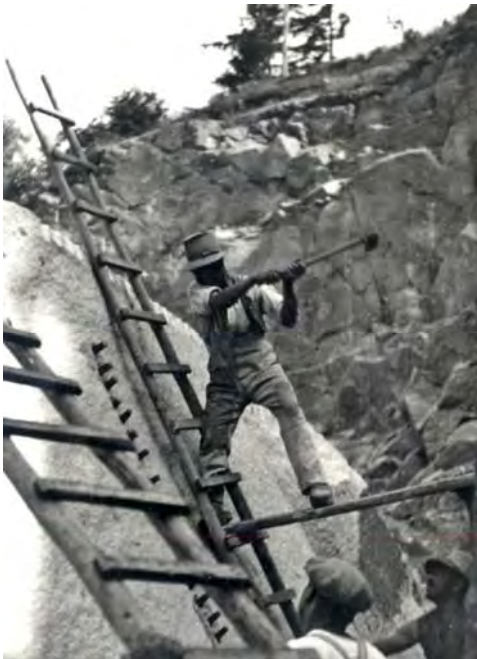
Abb. 33: Steinbruchkartei: Aufnahme des Steinbruchs Riedberg der Granitwerke August Kapsreiter, Schärding. GBA, LA (Reproduktion: GBA)
