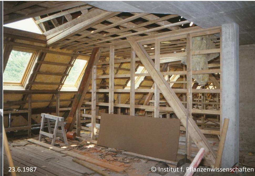
l.: Die unglaublich mächtigen Trame wurden durchschnitten und mit Stahlbändern gesichert, damit die Auflagen (Armierung schon vorhanden) für den Boden betoniert werden konnten. – r.: Durch die Holzgerippe, an denen dann die Gipsplatten befestigt wurden, zeichnen sich die Arbeitsräume bereits ab.
