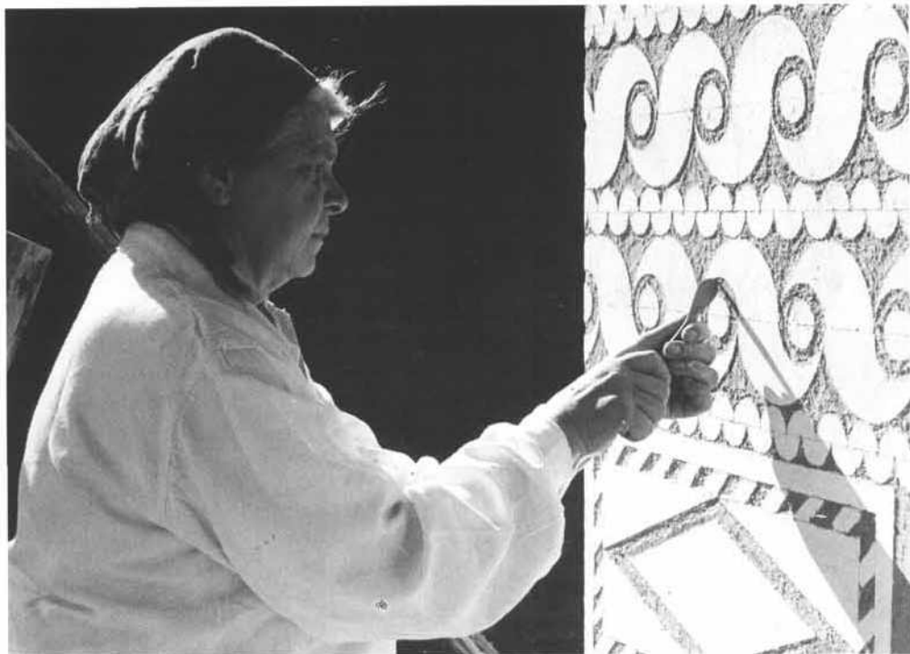
Die Künstlerin hoch am Gerüst beim Sgraffitoschneiden; Vierkanthof aus St. Ulrich bei Steyr im Österreichischen Freilichtmuseum Stübing. Foto: Otto Götzinger
