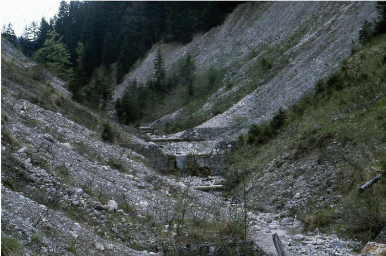
**Bild 34:** Abfluss- und Abtragsprozesse in Wildbacheinzugsgebieten. Wildbachsperre zur Kontrolle der Abfluss- und Abtragsprozesse. (Foto: T. Schauer).
