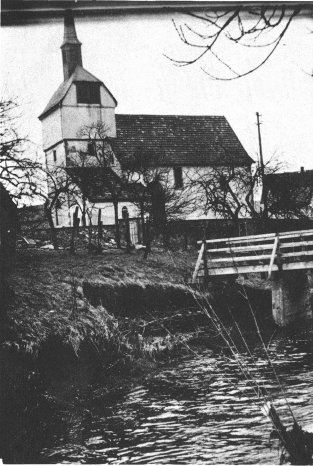
Abb. 4: Die alte Pfarrkirche (Wehrkirche) in Lahrbach.
