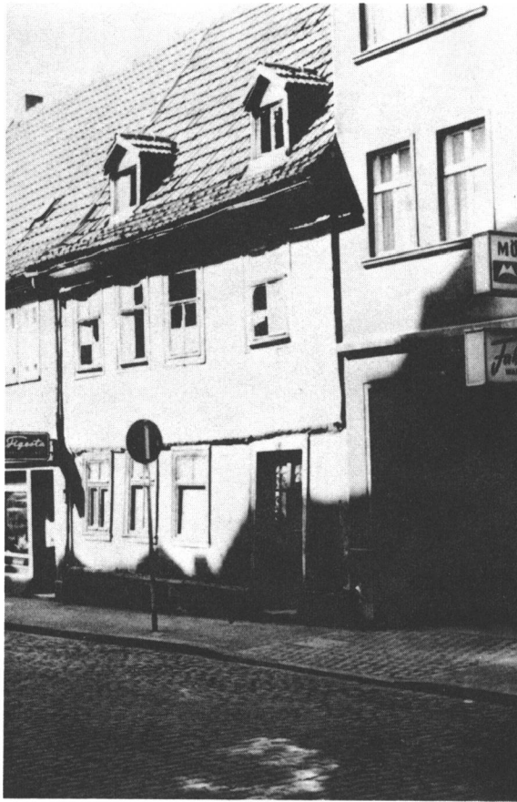
Abb. 1: Geburtshaus Adalbert R i c k e n s in Fulda (mit zerbrochenen Fenstern. Das Haus wurde inzwischen wegen Baufälligkeit abgebrochen).
