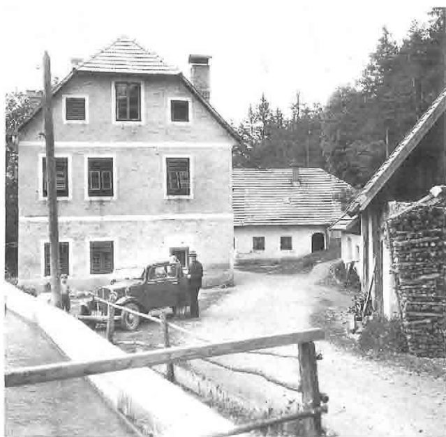
Abb. 11: Gebäude des „Jaklin-Hammers“ (1952)
